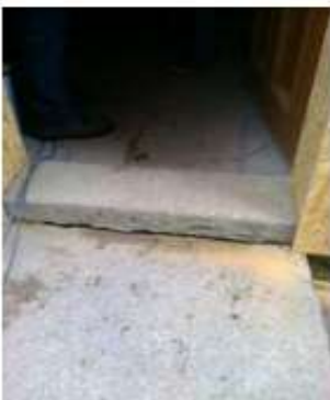
Ad e) výměna betonového prahu za kamenný
