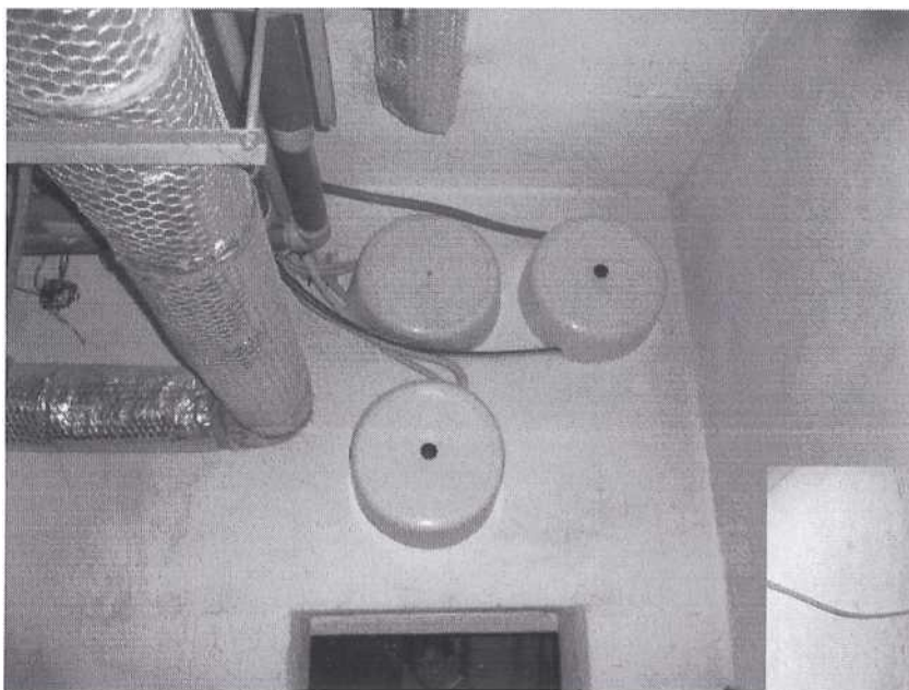
Rezervy stávajících optických kabelů ve spojovacím objektu A/B – 1.PP a vyvedení v tech. místnosti A012 v pav. B – 1.NP
