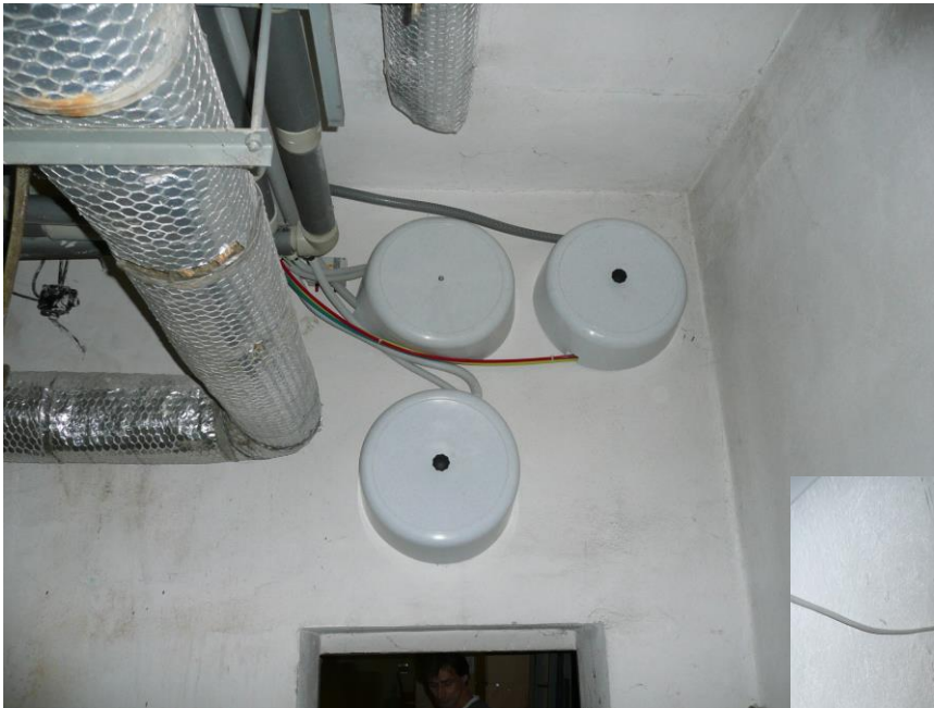
Rezervy stávajících optických kabelů ve spojovacím objektu A/B – 1.PP a vyvedení v tech. místnosti A012 v pav. B – 1.NP
