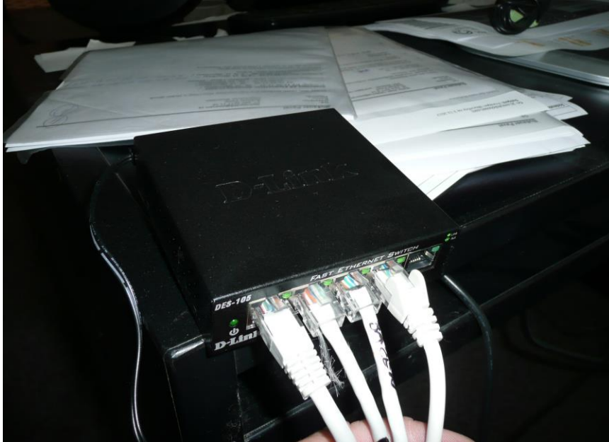
Switch v m.č. T27 – pav. TV – 1.NP
