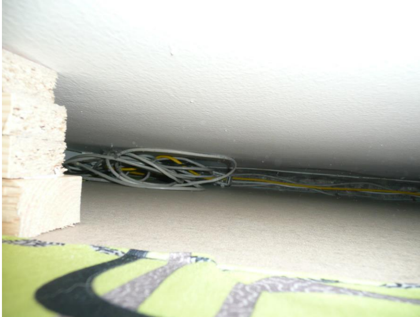
Switch v kabinetu tělocvičny č. 126 – 1.NP (ZŠ)
