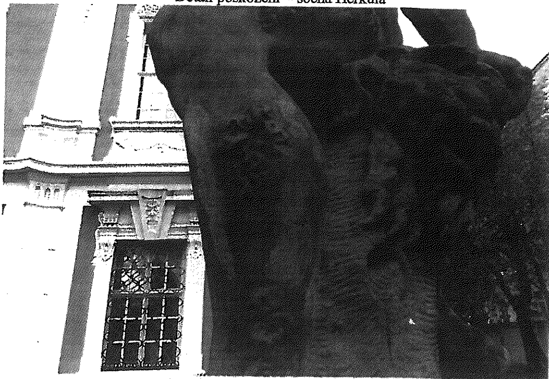
Detail poškození - socha Herkula
