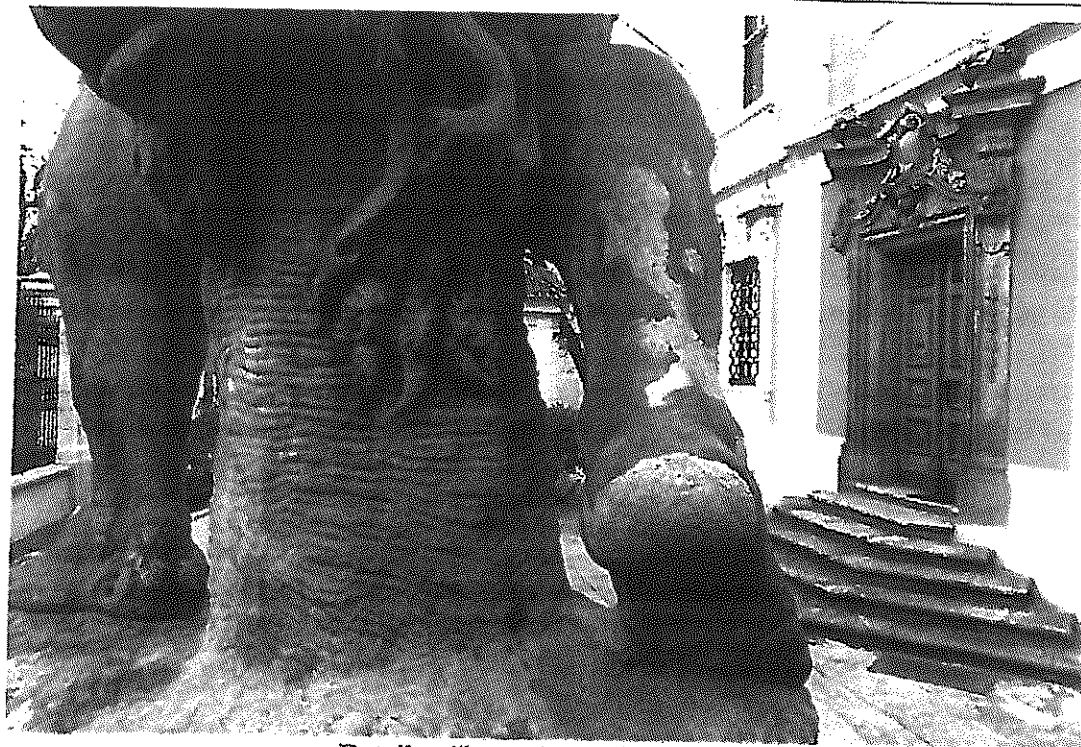
Detail poškození - socha Herkula
