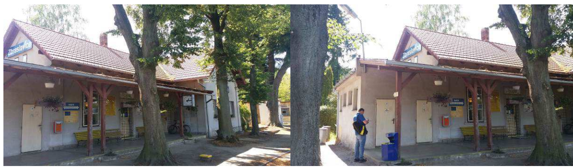
Výpravní budova – severní pohled
