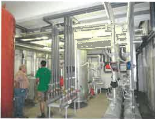
Obr. 11, 12: Výměníková stanice SZT, v opraveném stavu jsou izolace potrubních rozvodů
