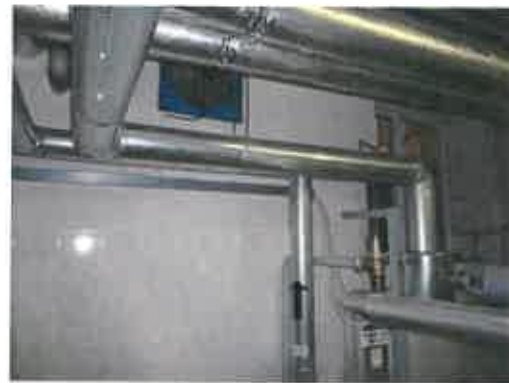
Obr. 11, 12: Výměníková stanice SZT, v opraveném stavu jsou izolace potrubních rozvodů
