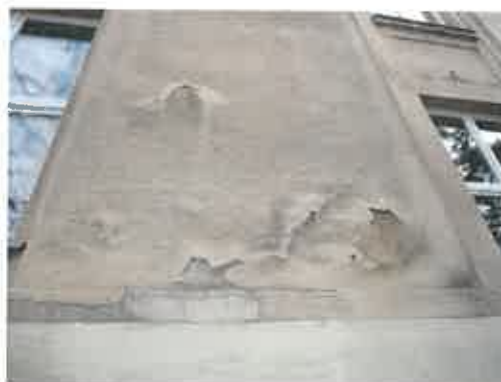
obr. 4: Na fasádě jsou praskliny, omítka odpadává
