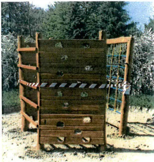
foto z instalace dětského prvku
