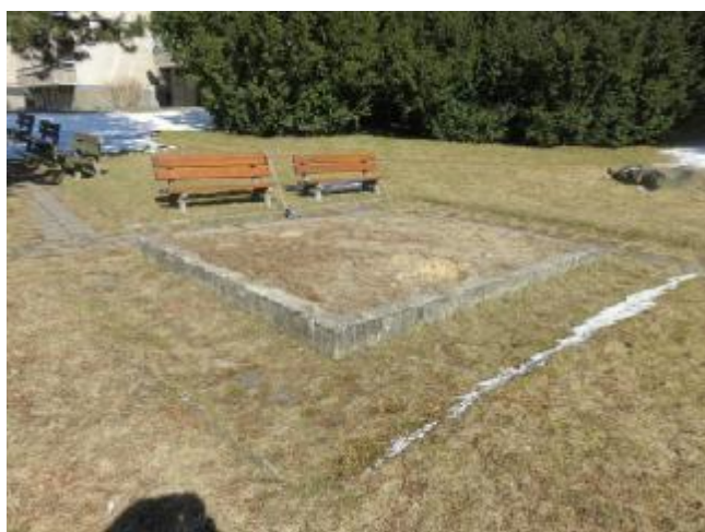
Dožívající nefunkční a nebezpečné herní prvky k výměně nebo k likvidaci, lavičky k repasi či odstranění, rozpadlá betonová dlažba s obrubou k obnově povrchu odpočívadla a navazujících pěšin
