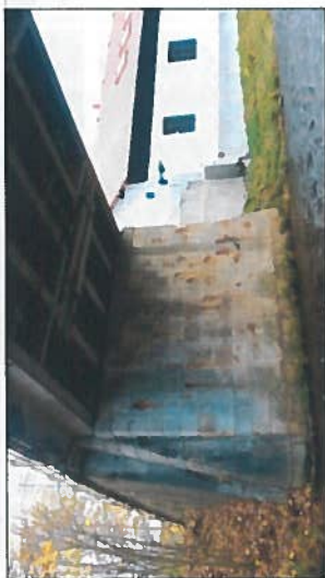
Pohled na líc opěry 1
