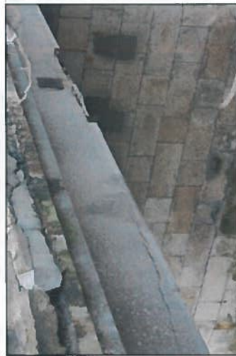
Ponuchy NK a firma
