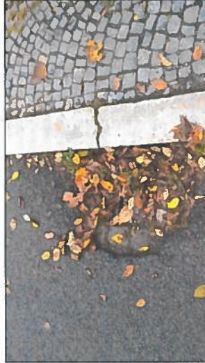
Zanesení mostní ochranné
