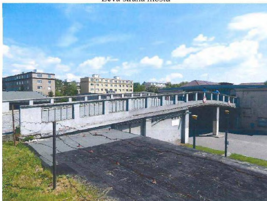
Pravá strana mostu
