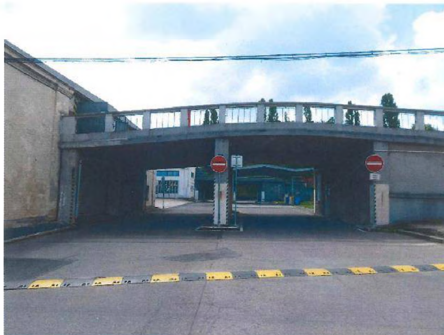
Levá strana mostu
