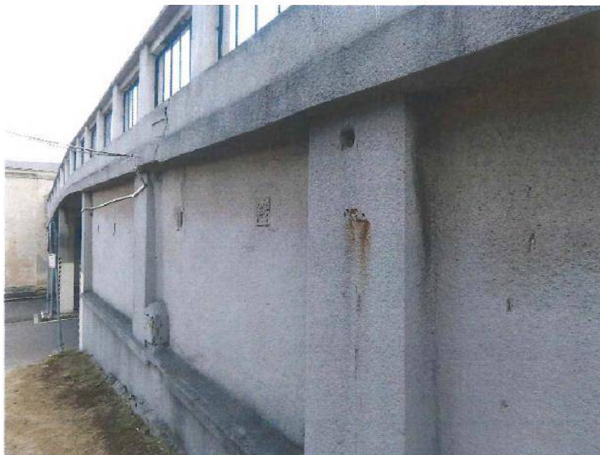
Opěry mostu určené k částečné sanaci
