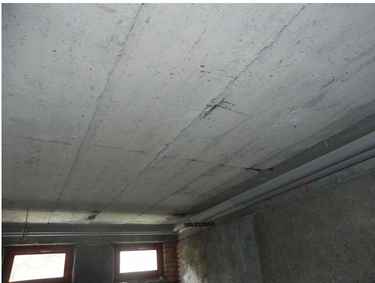
DETAIL D1 – ŠPATNÝ STAV STROPNÍHO PANELU – V PANELU JSOU DÍRY
