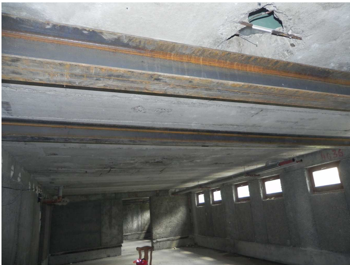
DETAIL D2 –ŠPATNÝ STAV STROPNÍCH PANELŮ – NOSNÁ VÝZTUŽ JE ZNAČNĚ NARUŠENA KOROZÍ , V PANELECH JSOU DÍRY
