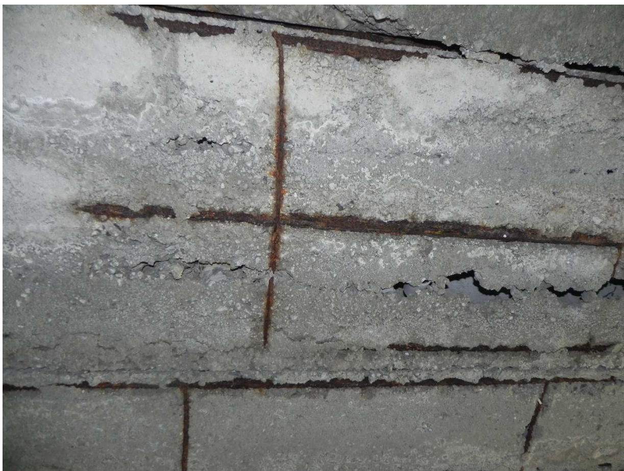
DETAIL D2 –ŠPATNÝ STAV STROPNÍCH PANELŮ – NOSNÁ VÝZTUŽ JE ZNAČNĚ NARUŠENA KOROZÍ , V PANELECH JSOU DÍRY
