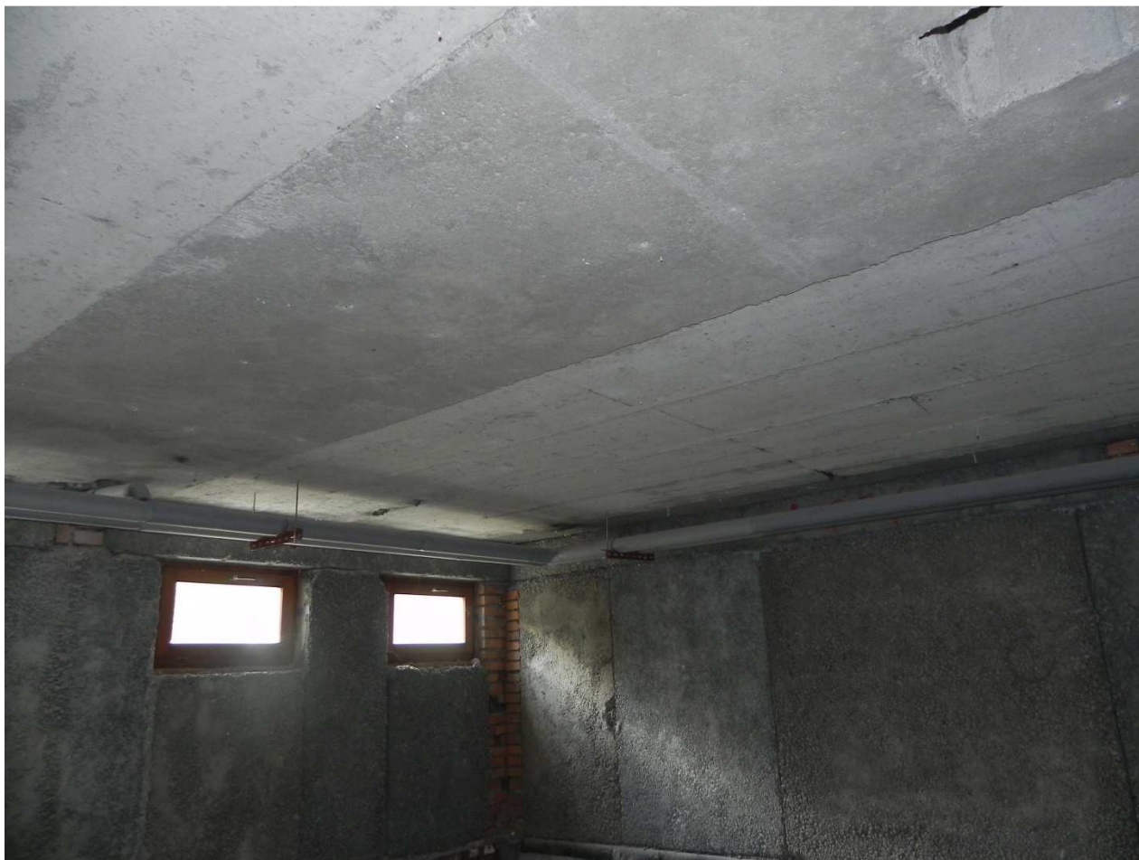
DETAIL D1 – ŠPATNÝ STAV STROPNÍHO PANELU – V PANELU JSOU DÍRY
