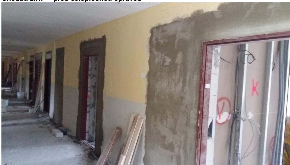
Chodba 2.NP – před celoplošnou opravou
