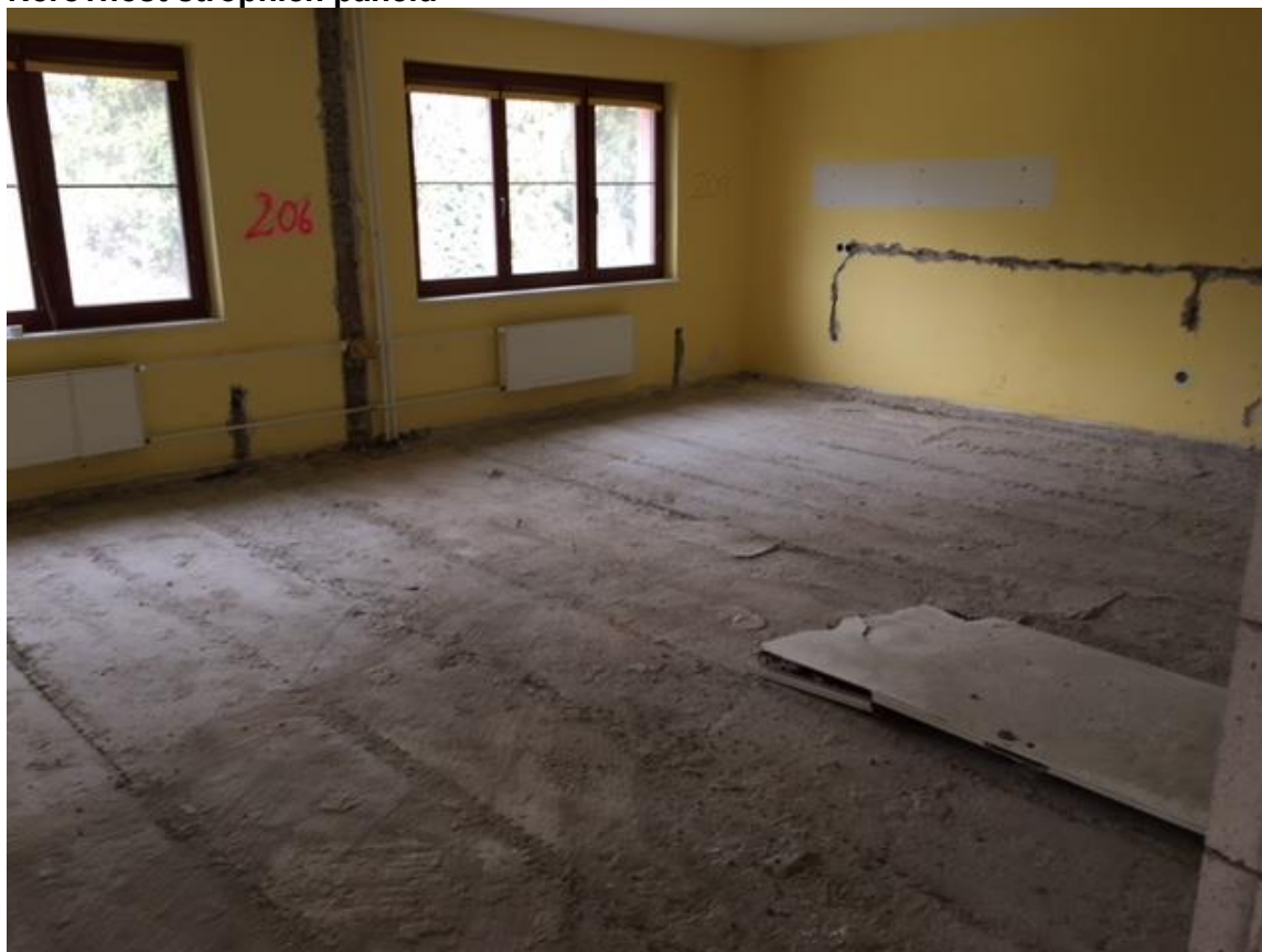
Nerovnost stropních panelů
