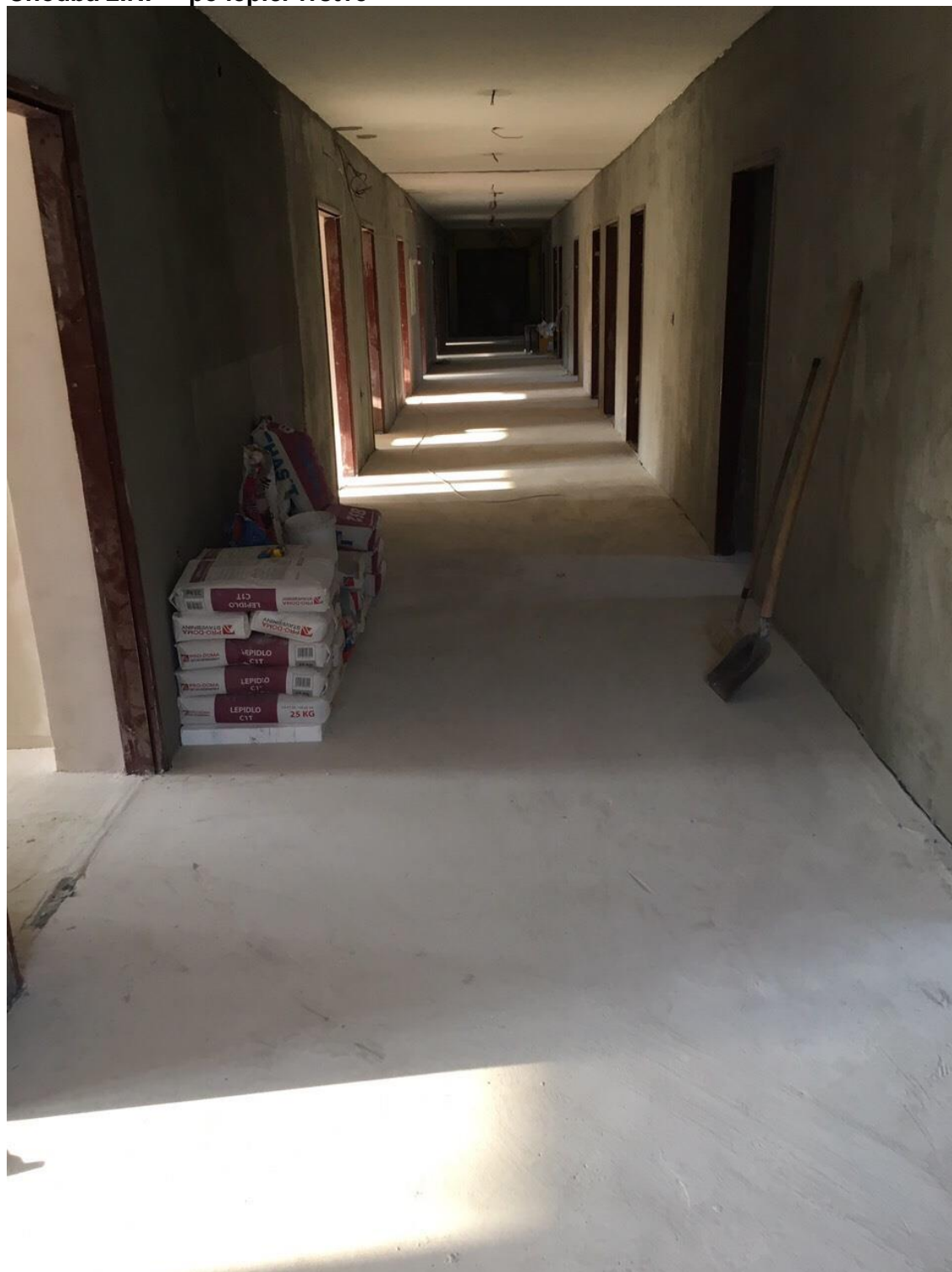
Chodba 2.NP – po lepící vrstvě
