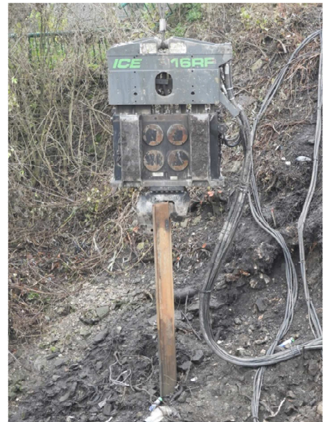
Obr. 5: vibrační beranidlo ICE 16RF
