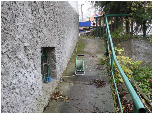
Obr. 6: snímač SN1 na sklepním okně
