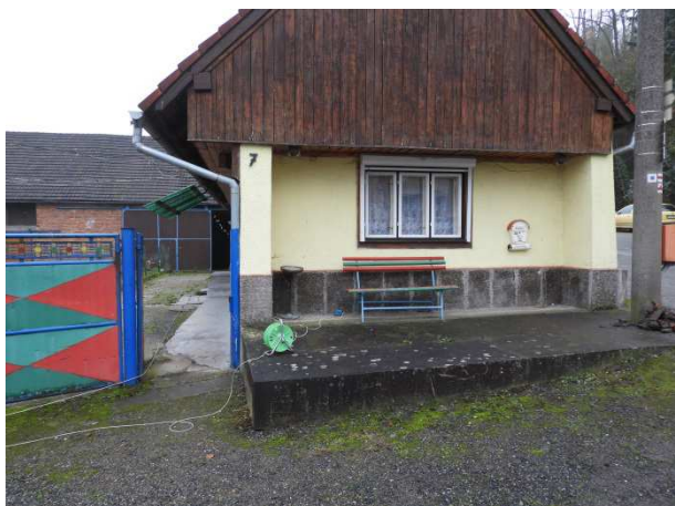
Obr. 8: snímač SN4 v čele objektu
