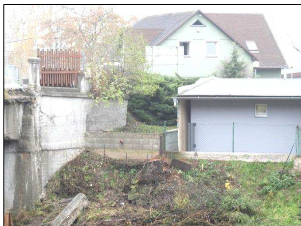
Obr. 10: Pohled na objekt č. p. 79 a opěru stávajícího mostu
