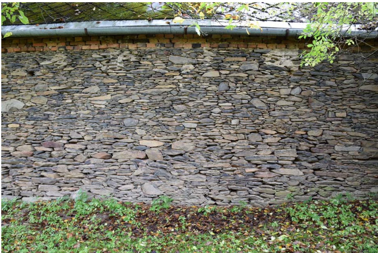
Detail kamenného zdiva hlavní budovy usedlosti čp. 31.
