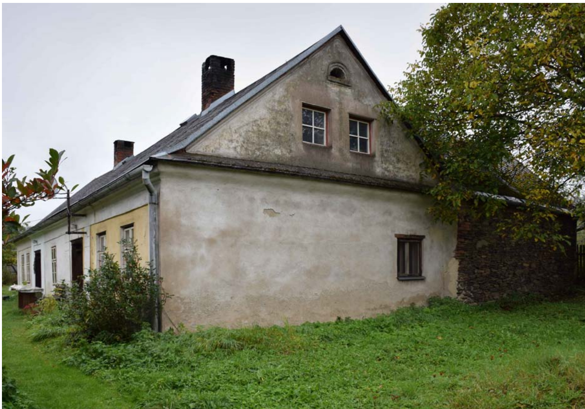
Pohled na hlavní budovu usedlosti čp. 31 od severovýchodu.
