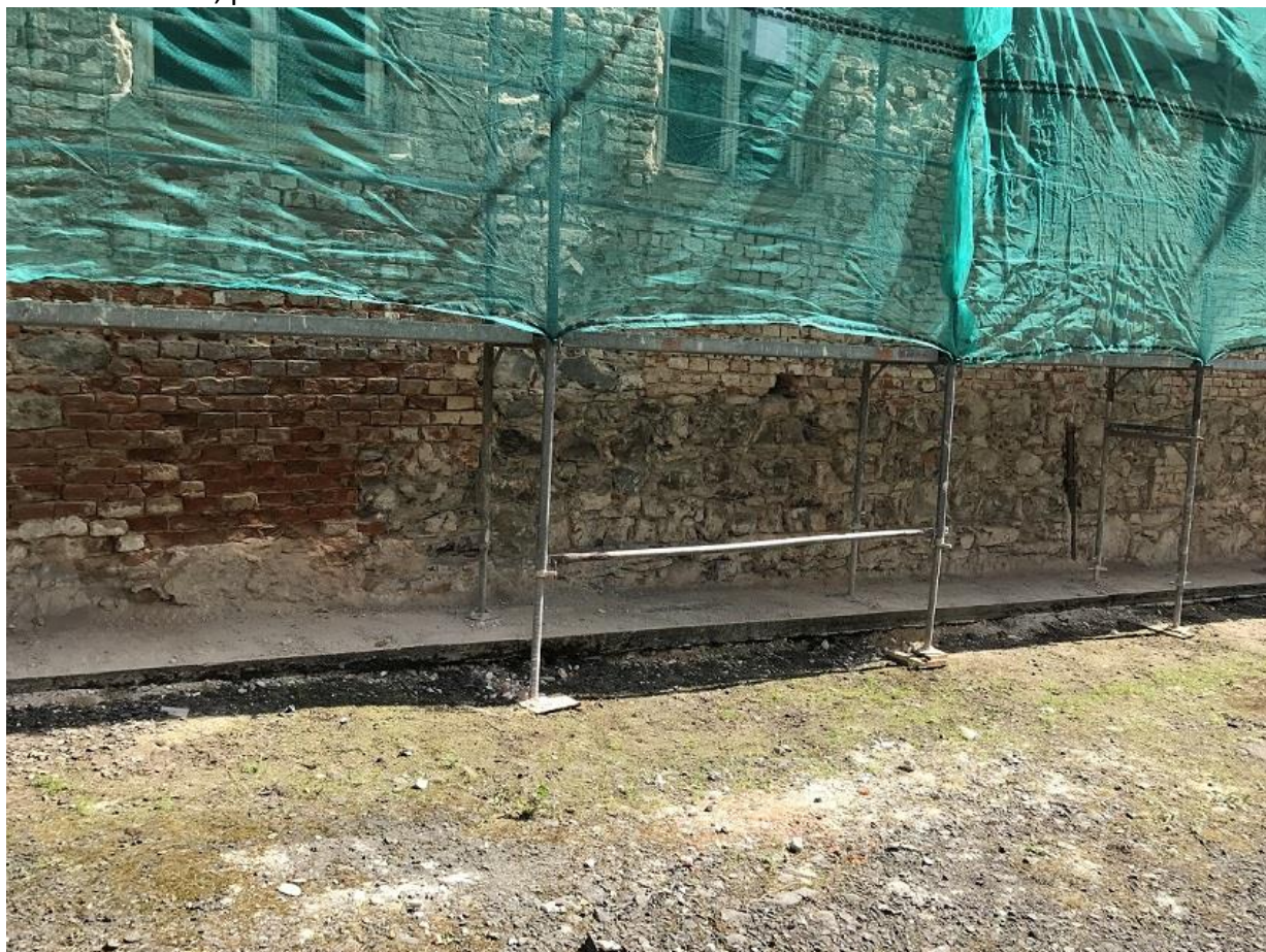
Obvodové zdivo, po otlučení omítek
