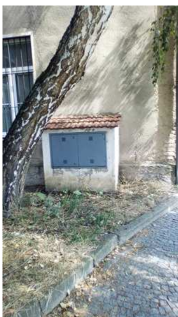
Kiosek zrušeného plynovodu
