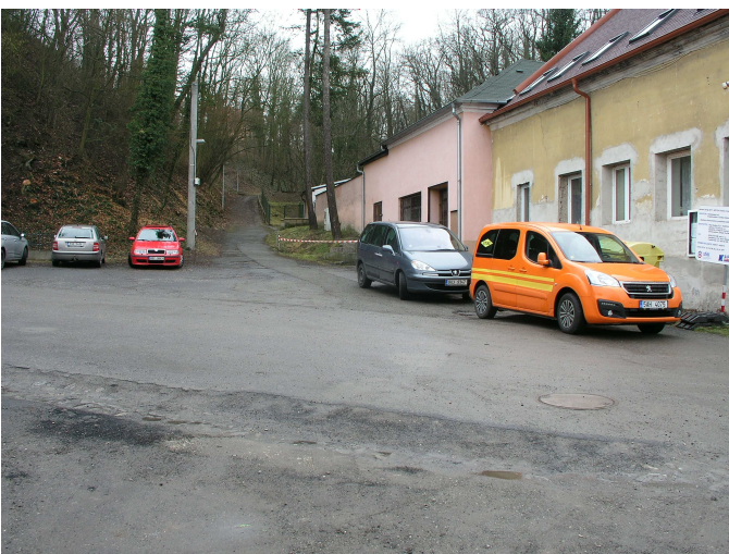
Erozní rýha nad mostem (zčásti zakryta objekty)
