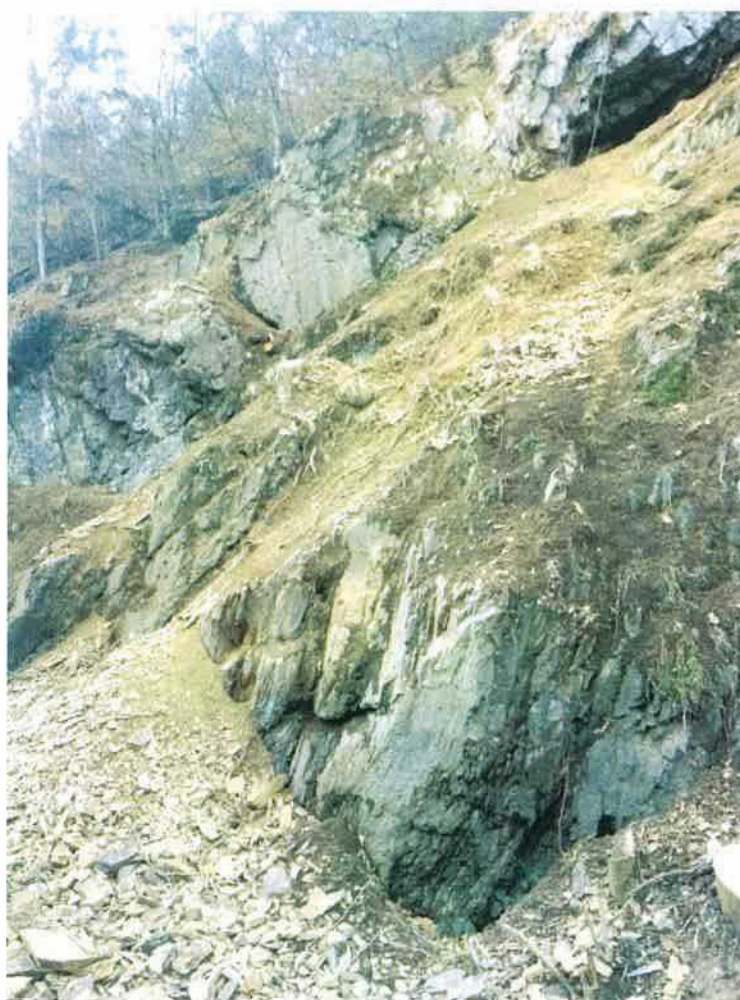
foto 2, SO 106, čištění skalní stěny, říjen / listopad 2017
