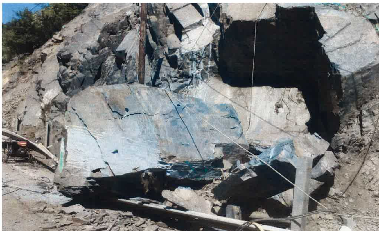
foto 2, SO 101, Dolam skal , květen 2017
