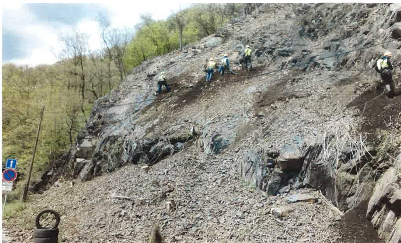
foto 1, SO 101, Očištění skalní stěny, květen 2017
