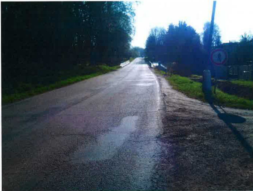
Silnice II/112 před mostem ev.č. 112-005
