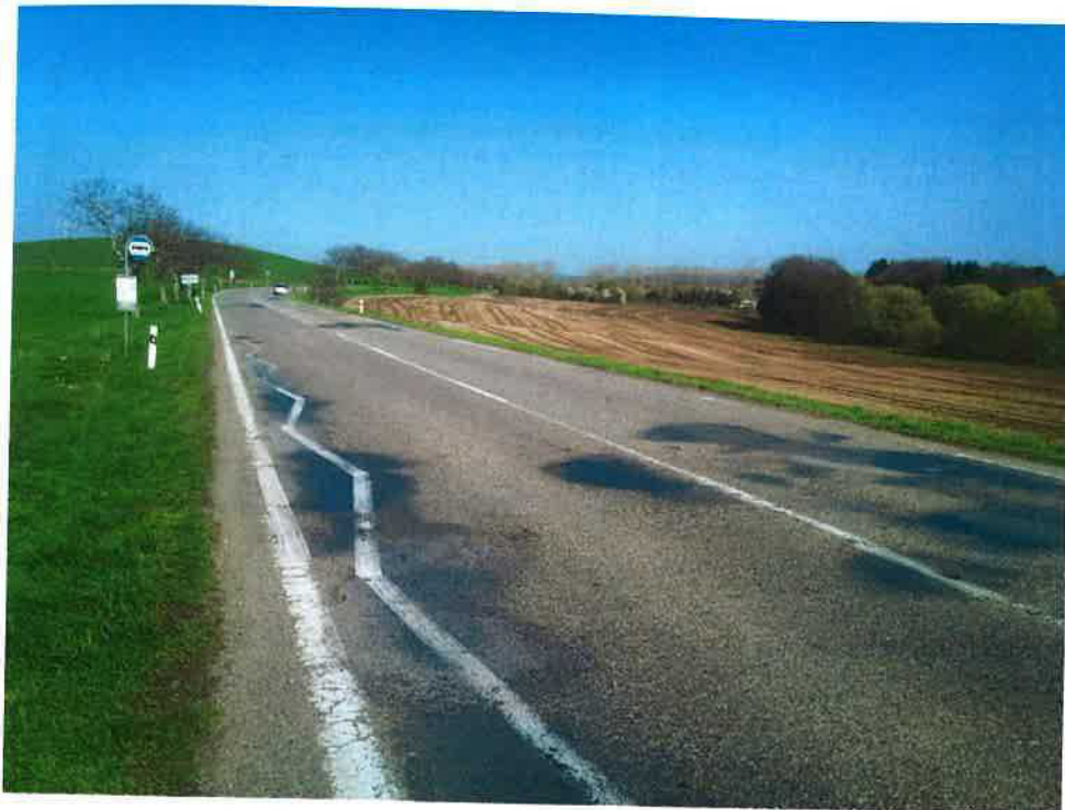
Silnice II/112 staničení cca 4,00 km
