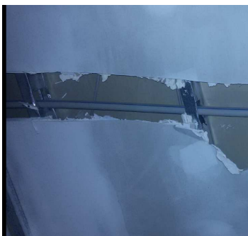
Sonda do stávající konstrukce
