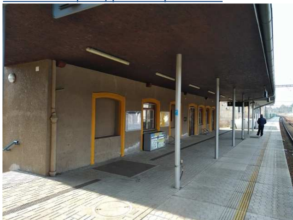
Parter nástupiště, pohled přístřešku
