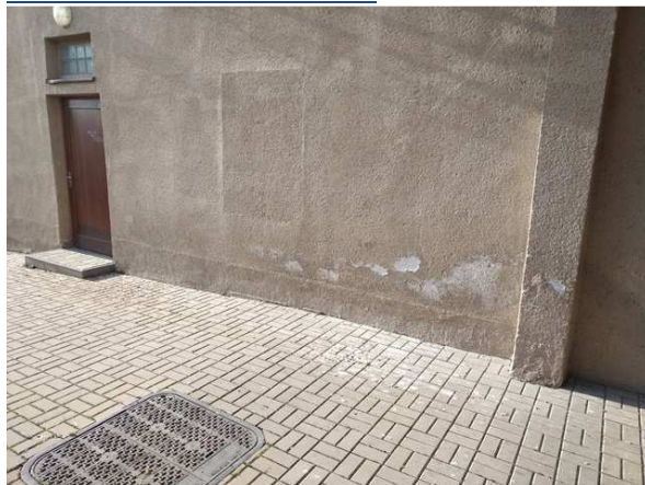
Boční fasáda u domečku WC
