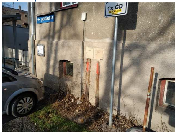
Sokl, sklepní okna
