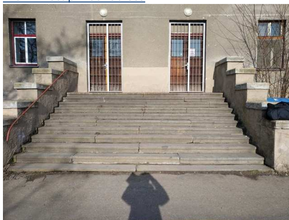
Hlavní vstupní schodiště
