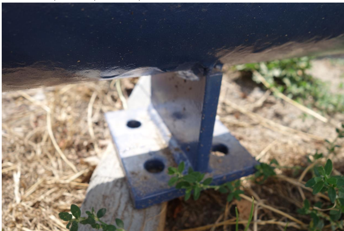
Obrč.4 kotevní patka bude po montáži opravena ručním nátěrem kombinací štětec - váleček
