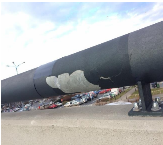
d) Plošina – madla na betonové zídce
