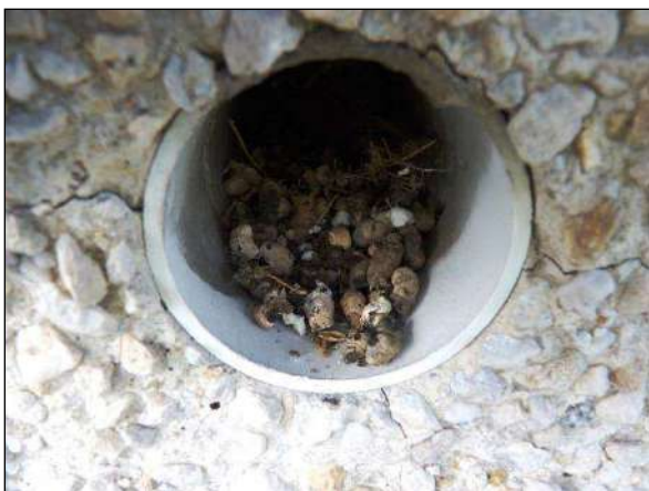
Trus rorýse obecného v ústí ventilačního otvoru
