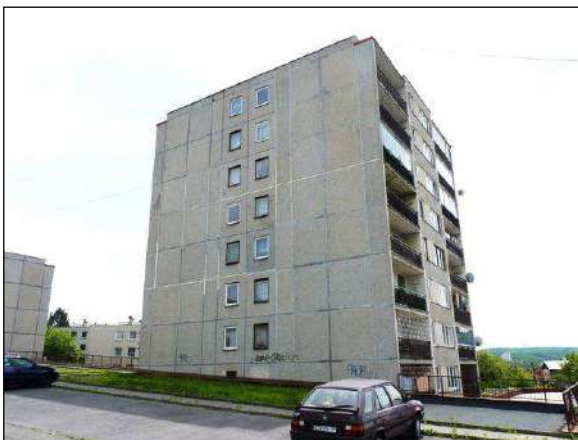
Panelový bytový dům
