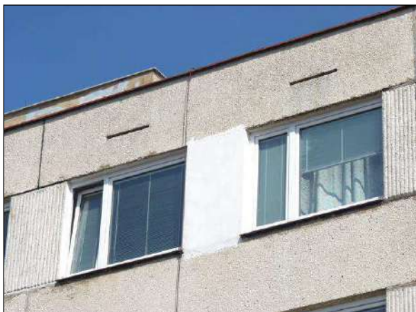
Detail atiky s ventilačními otvory
