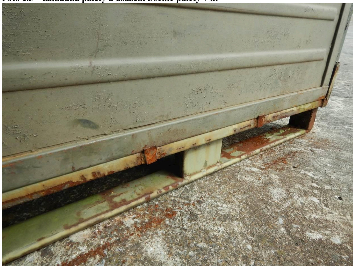
Foto č.5 – základna palety a usazení bočnic palety v ní
