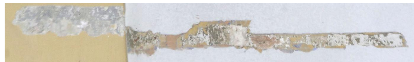
sondy P/20,P/21 - severní stěna presbytáře, pilastr1),2)- hrubší tmavě šedá vápenná omítková vrstva s výmalbou v šedě modrých odstínech,3)- vápenný pačok 4),5) - mladší hlínkové výmalby
