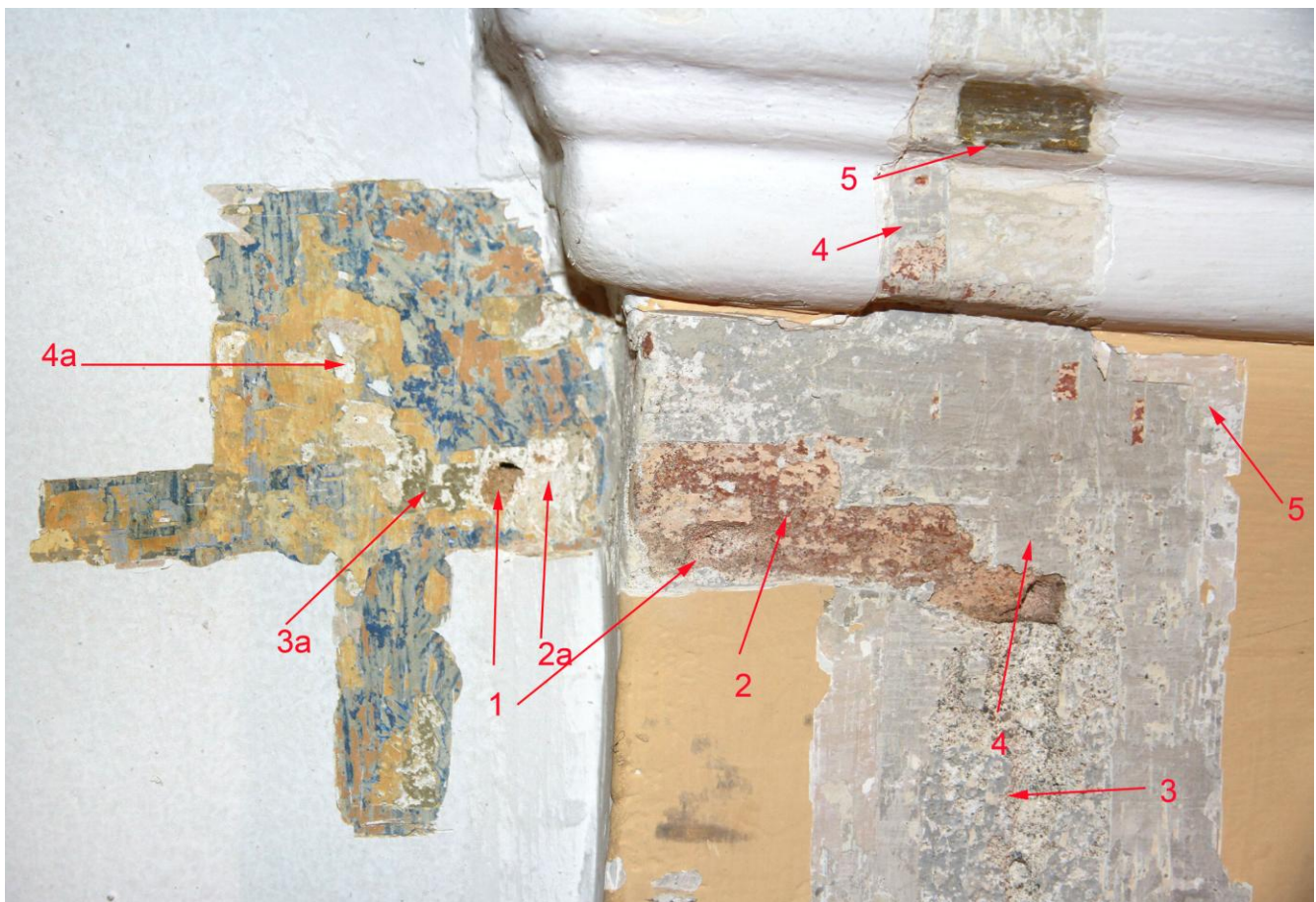
sonda P/17 - severní stěna presbytáře, hlavice pilastru 1)-jemná vápenná do růžova barvená originální omítka s vápenným pačkem 2)-červená výmalba pod hlavicí pilastru 3)- hrubší tmavě šedá vápenná omítková vrstva s výmalbou v šedě modrých odstínech, 4),5) - mladší vápenné vrstvy v šedých odstínech, 2a)- vápenné vrstvy,3a),4a)- mladší hlínkové výmalby
