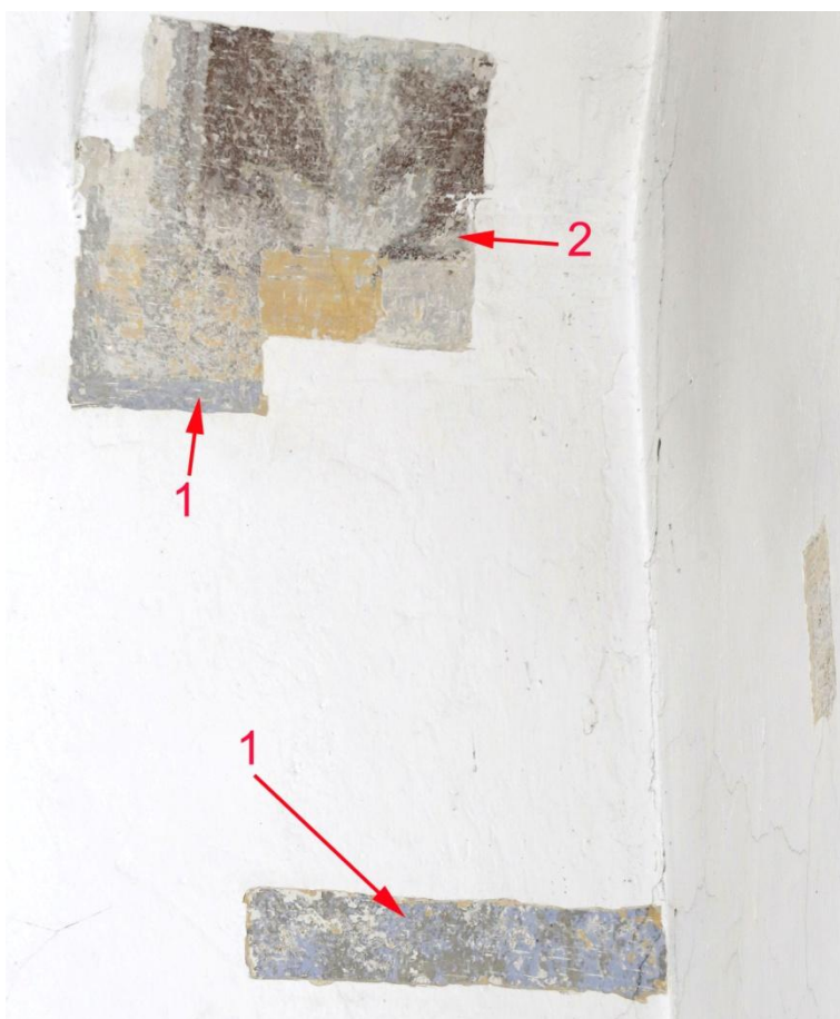
sondy K/3- východní a jižní stěna kůru,1)- hrubší tmavě šedá vápenná omítková vrstva s výmalbou v šedě modrých odstínech,2) - mladší hlínkové výmalby
