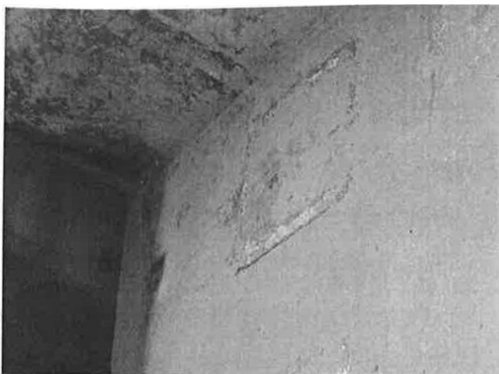
DTTO - separace dobetonávky kotvy příčného předpětí
