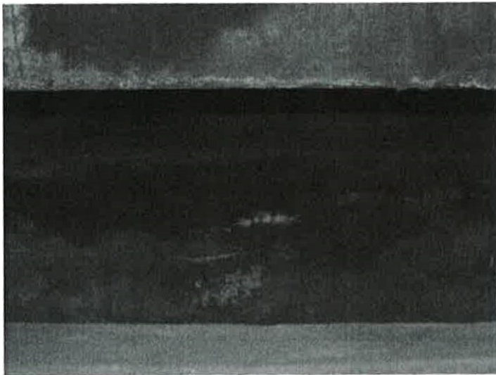
příčné trhliny s masivními výluhy pojiva na spodním líci konzoly ZZ OI
