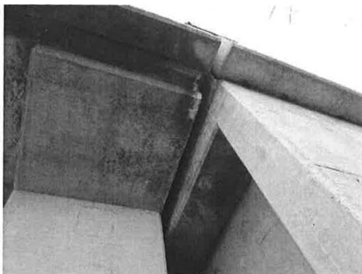
pravá konzola - pohled na spodní líc pravé konzoly nad 08
