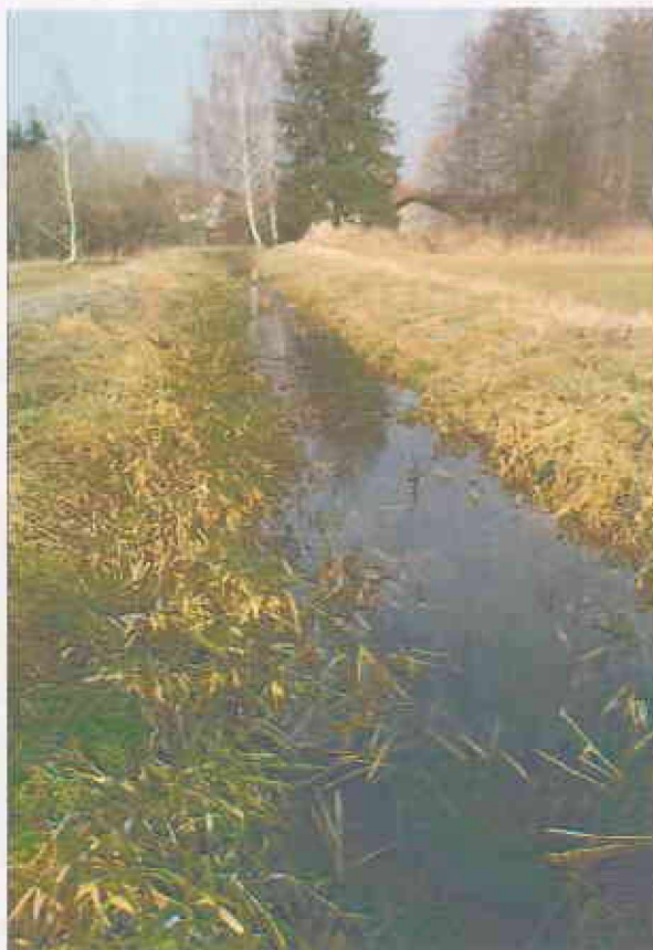
Obr. 6 - Stav přítokového koryta
