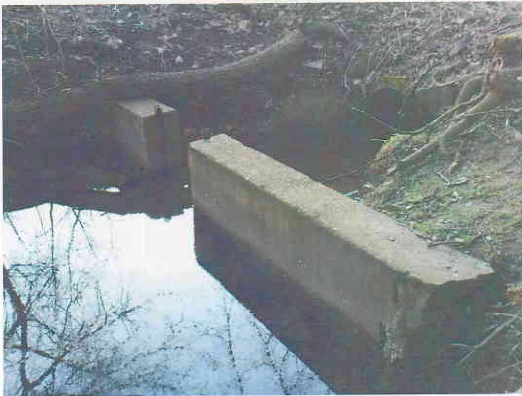
Obr. 4 - současný upravený vtok do nádrže
