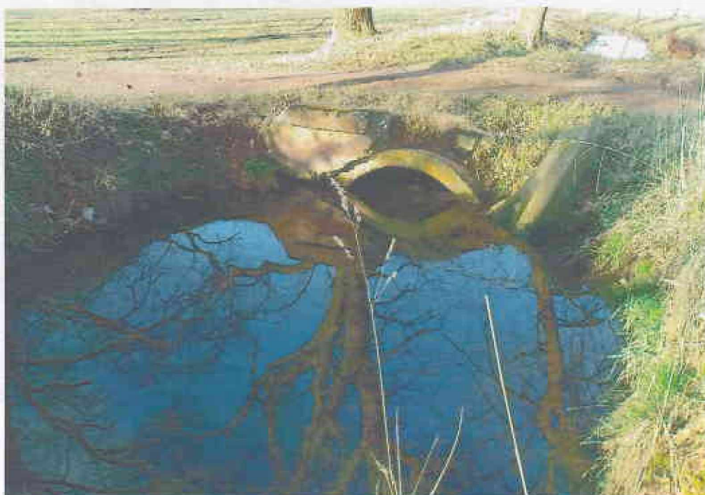
Obr. 7 - Stav trubní propusti
