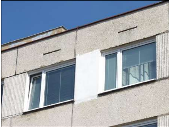
Detail atiky s ventilačními otvory
