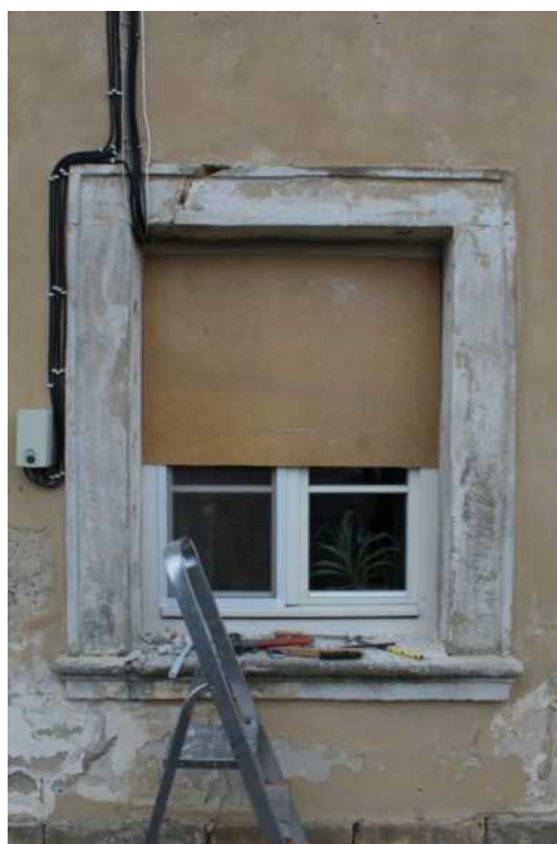
Průběh čištění a snímání štukového překryvu.
