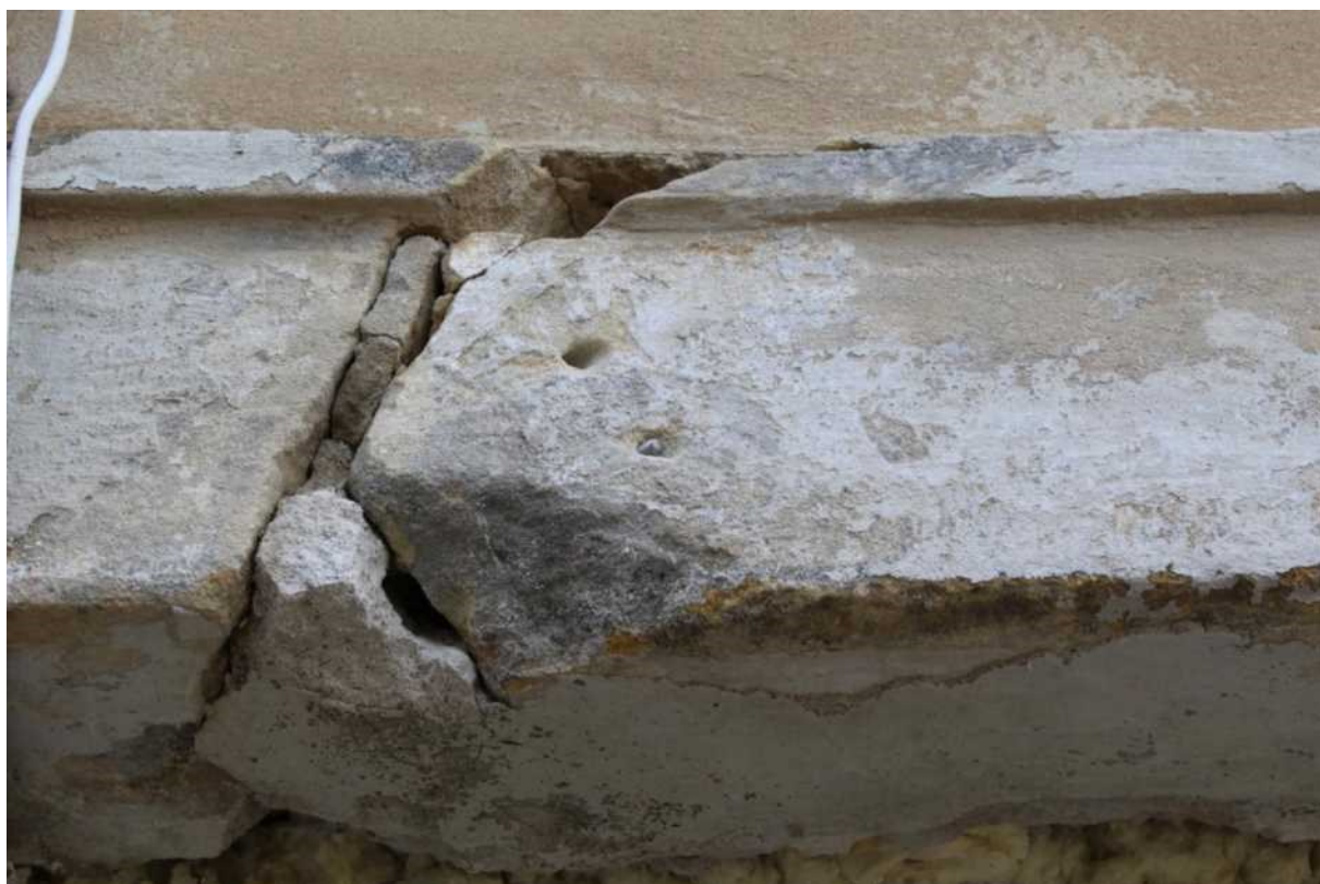
Prasklina v překladu bude fixována nerezovým čepem.
