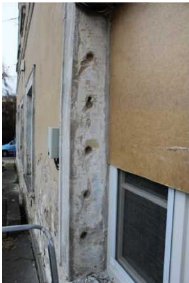
Otvory po osazených mřížích v ostění. Detail ostění před očištěním.
