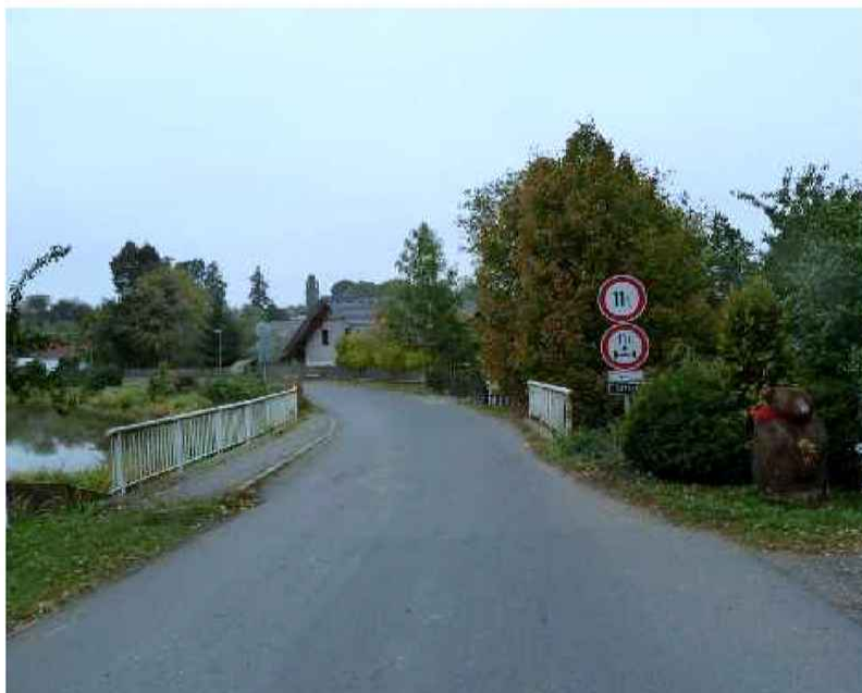
Pohled po směru staničení.
