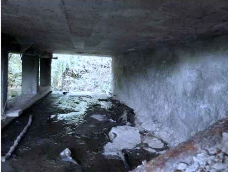
Podhled NK, provizorní podepření nosné konstrukce a opěra O1
