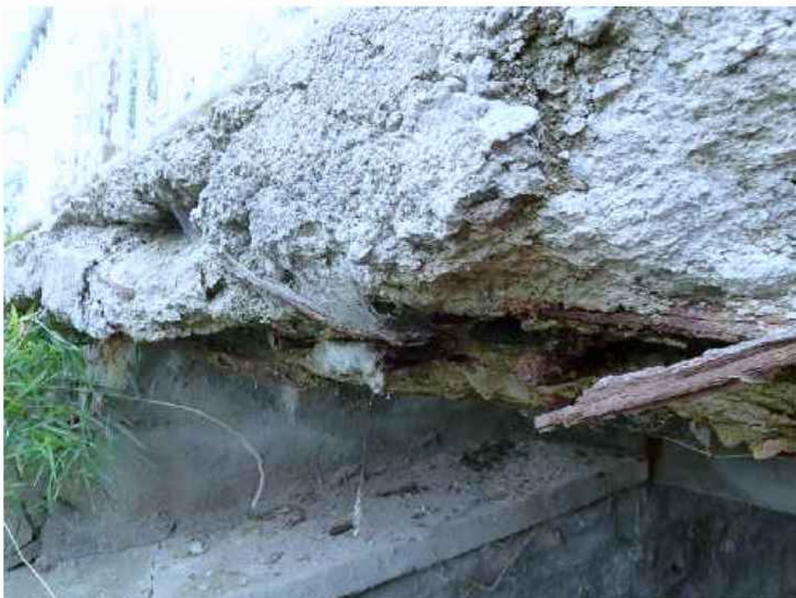
Detail levé římsy.
