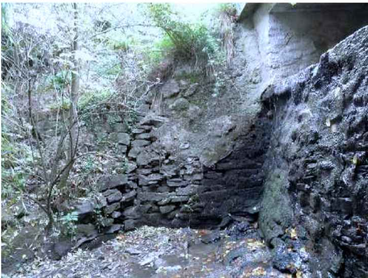
Pravé křídlo opěry O1.
