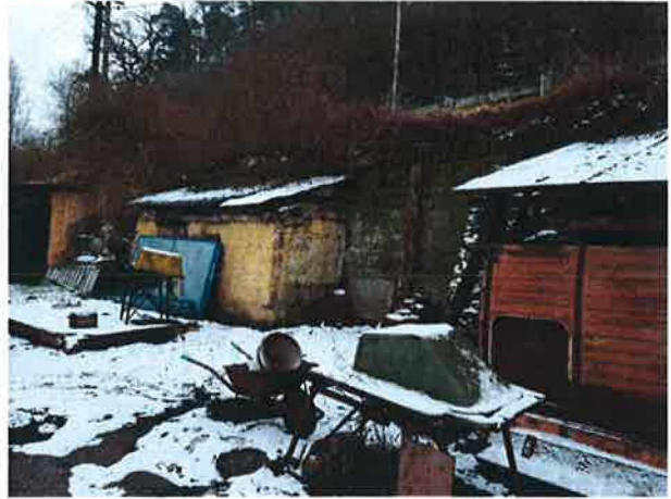
Obr. 2. Pohled na střední část opěrné zdi.
