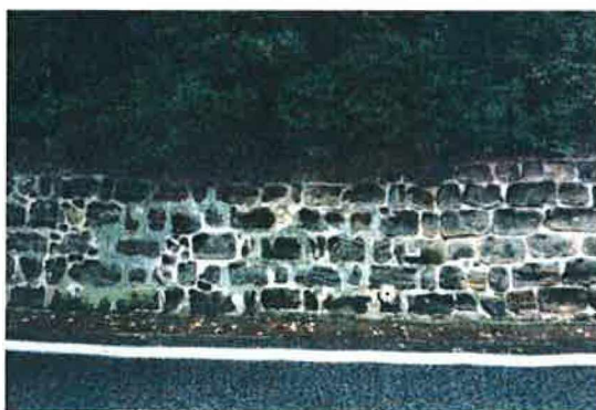
Stávající zárubní zed' při v. okraji vozovky.
