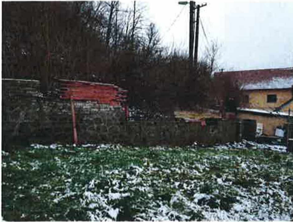
Obr. 1. Pohled na severní část opěrné zdi.
