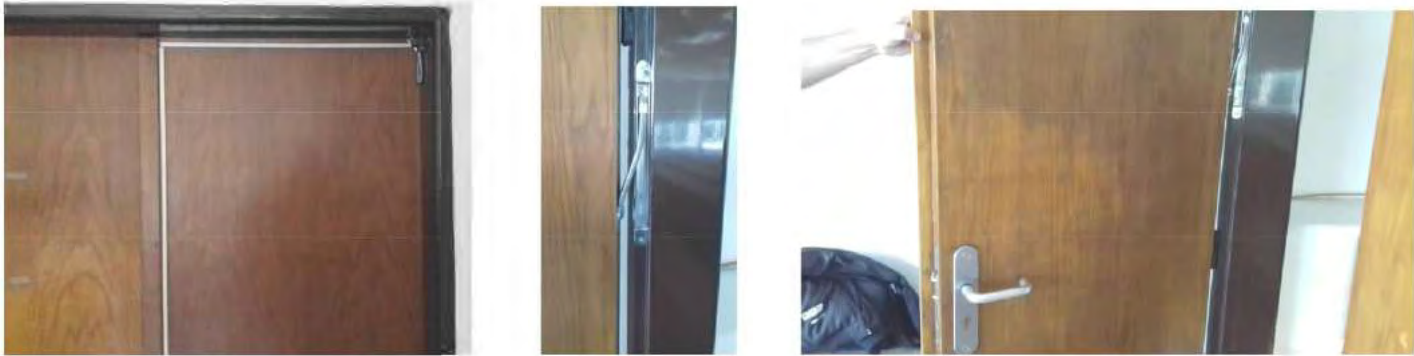
Součástí dodávky dveří bude bezpečnostní zámek a čtečka. /Foto - stávající stav/
