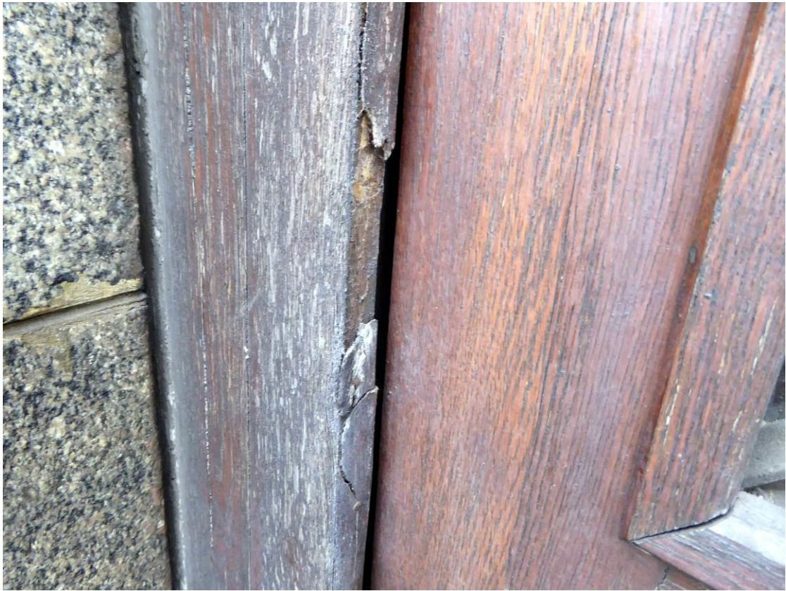
Detail zteřelého okraje rámu dveří
