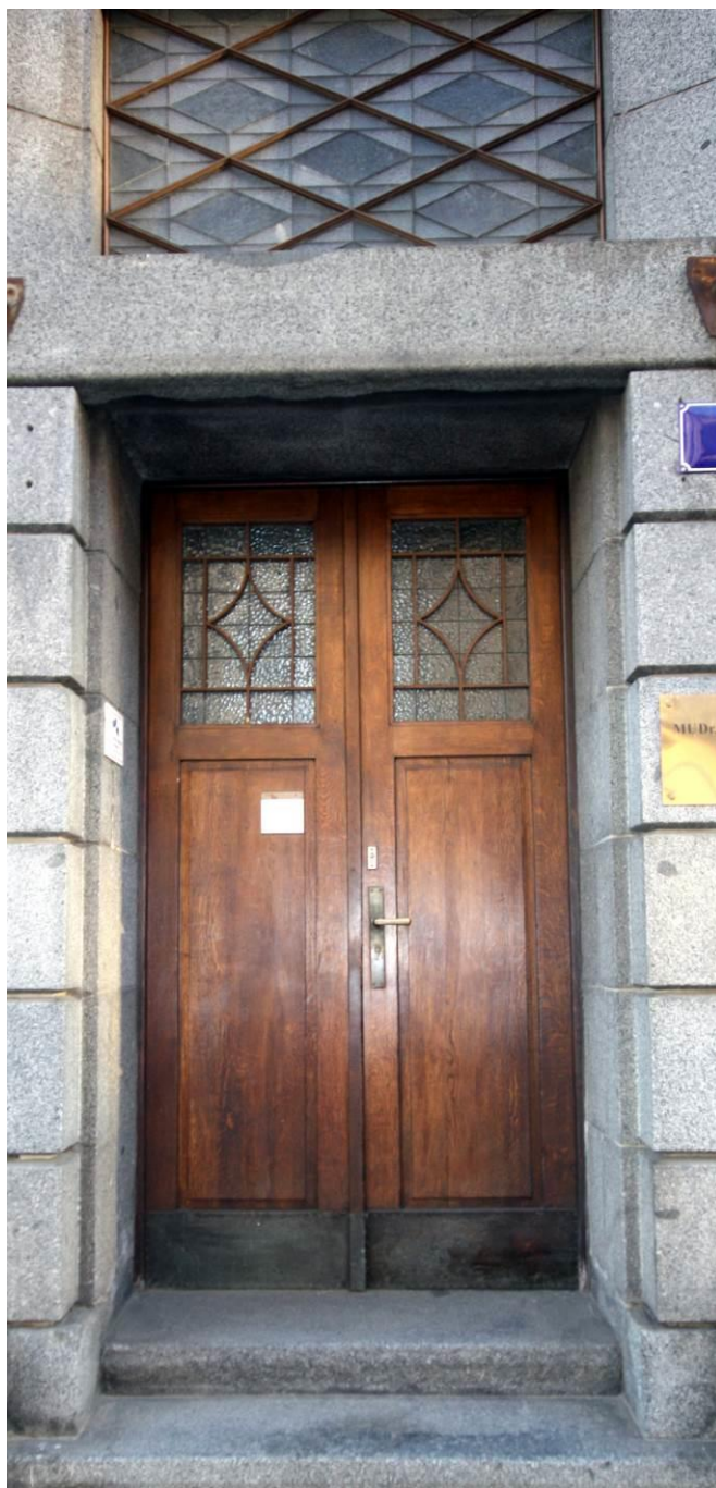
Celkový pohled na dveře s nadsvětlíkem
