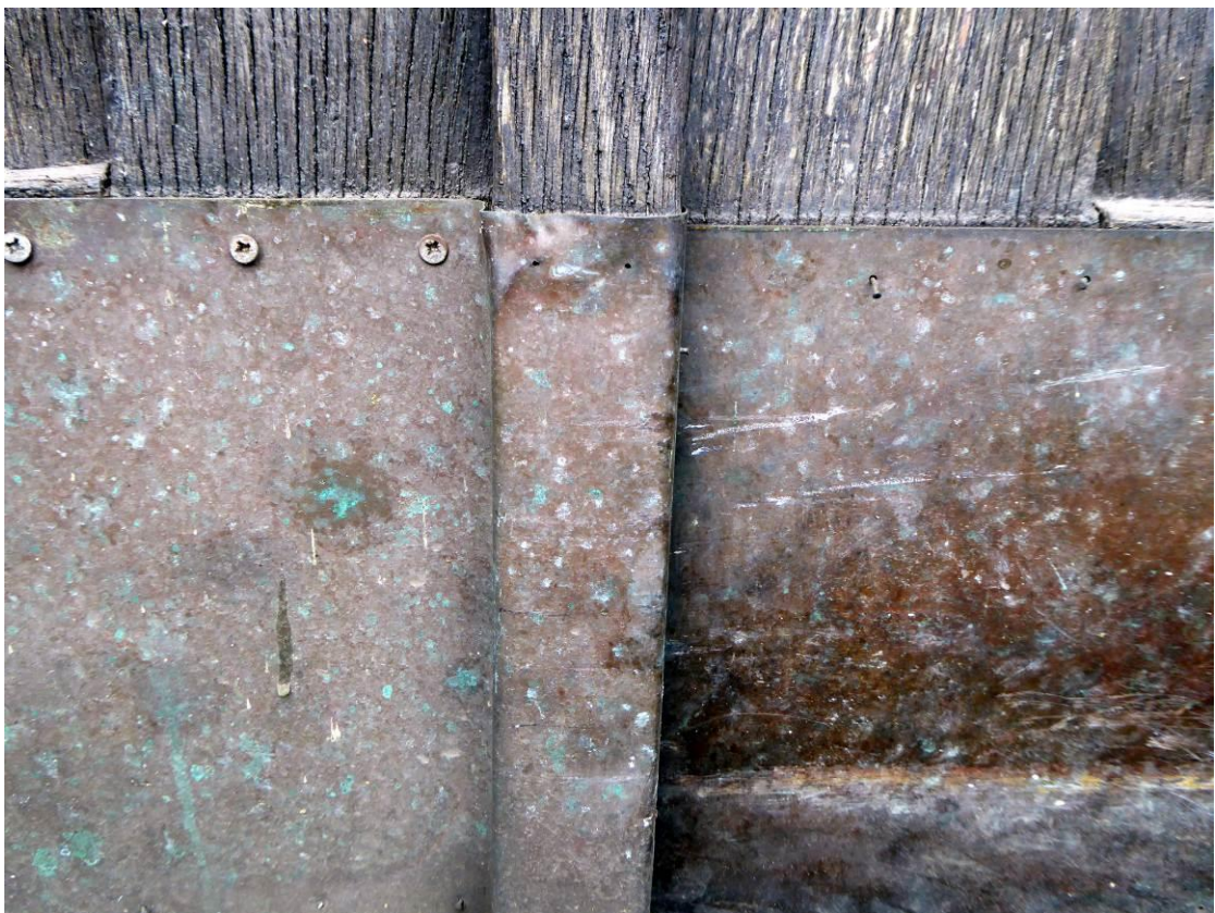
Detail nepůvodního měděného plechu
