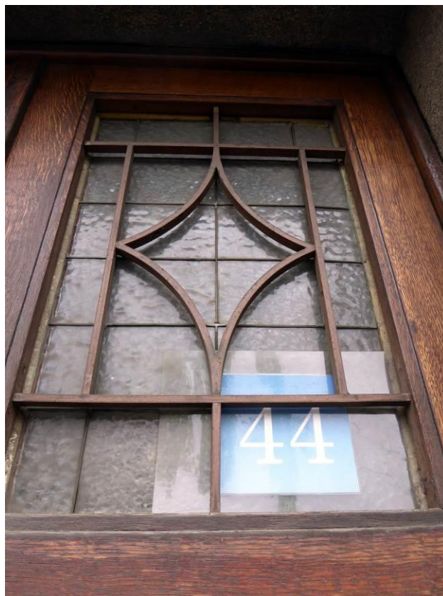
Detail původní mříže s vitrážovým oknem
