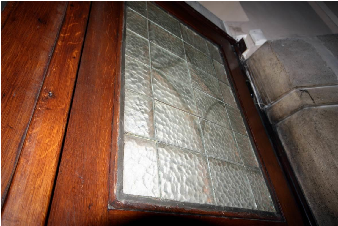
Detail osazení vitráže za mosaznou mříží
