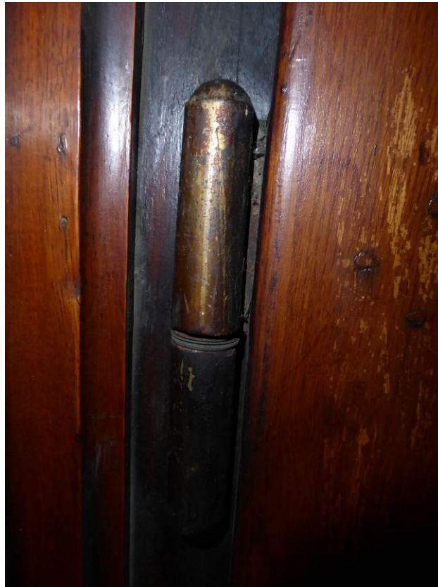
Detail mosazného návleku a závěsu dveří
