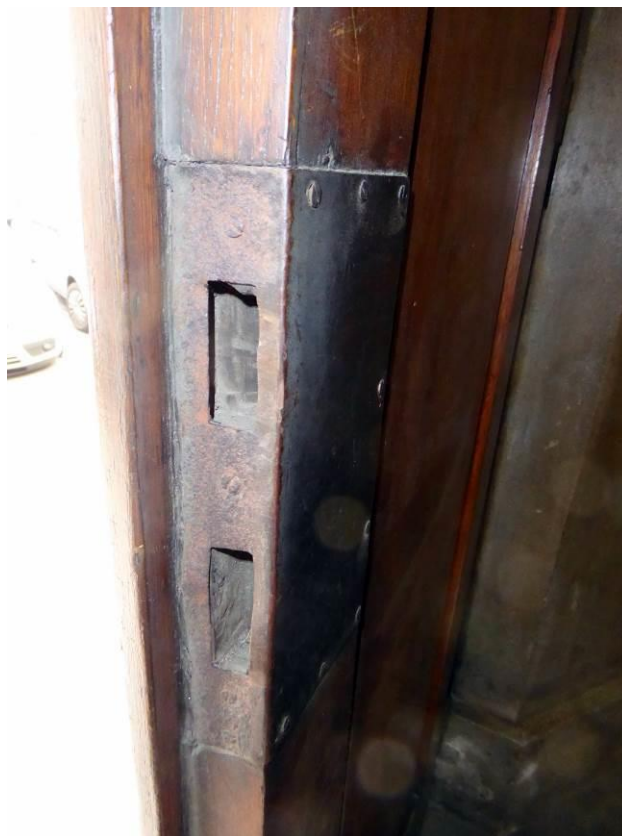
Detail masivního protiplechu zámku dveří
