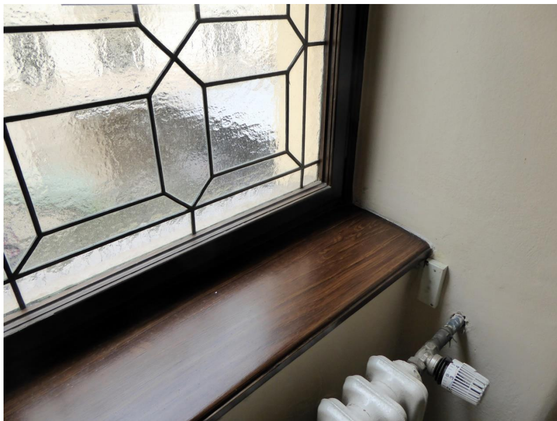
Pohled na parapetní prkno – stávající stav
