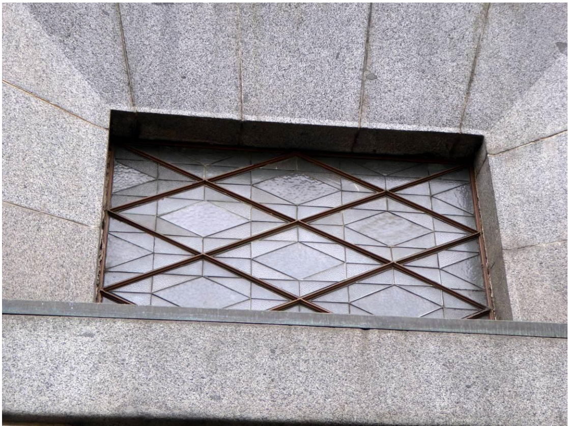
Nadsvětílková mříž s dekorativním prosklením tlačným sklem
