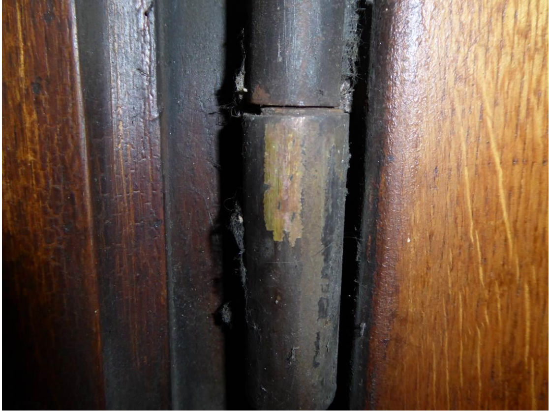
Detail návleku původního závěsu dveří
