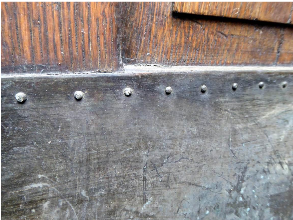
Detailní pohled na měděný plech s původními ozdobnými hřeby
