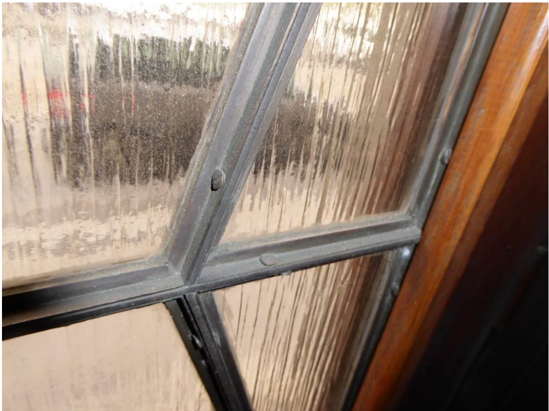
Detail mříže vstupních dveří – materiál bronz; šrouby s plochou hlavou
