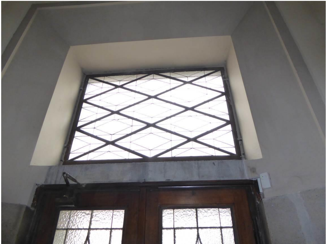
Detail horní části dveří s „branem“ a nadsvětíkovou mříží
