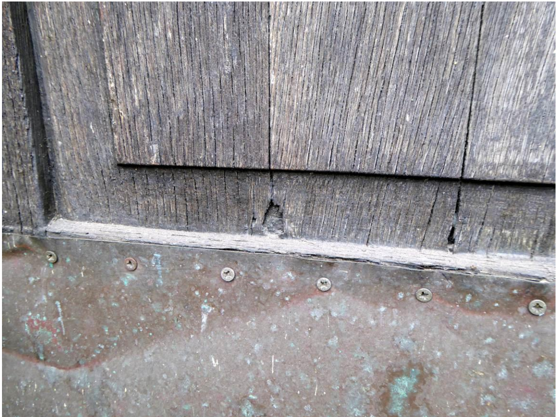
Detail rozpadajícího se dřeva na spodní části kazety pevného křídla
