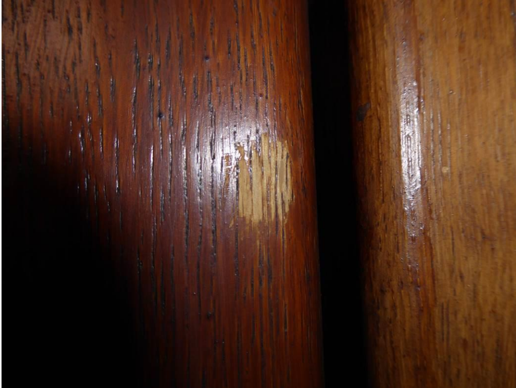
Sonda povrchu dubového dřeva na kyvných dveřích – dveře bez mořidla, pouze přibarvený lazurní lak
