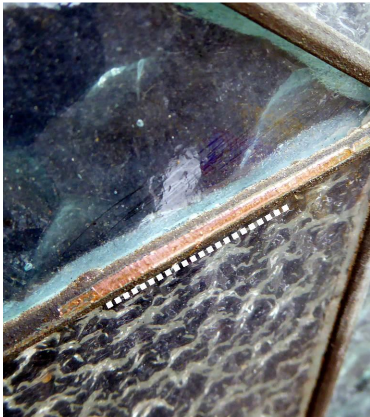
Materiálová sonda na fixační liště zasklení nadsvětlíku – mosaz
