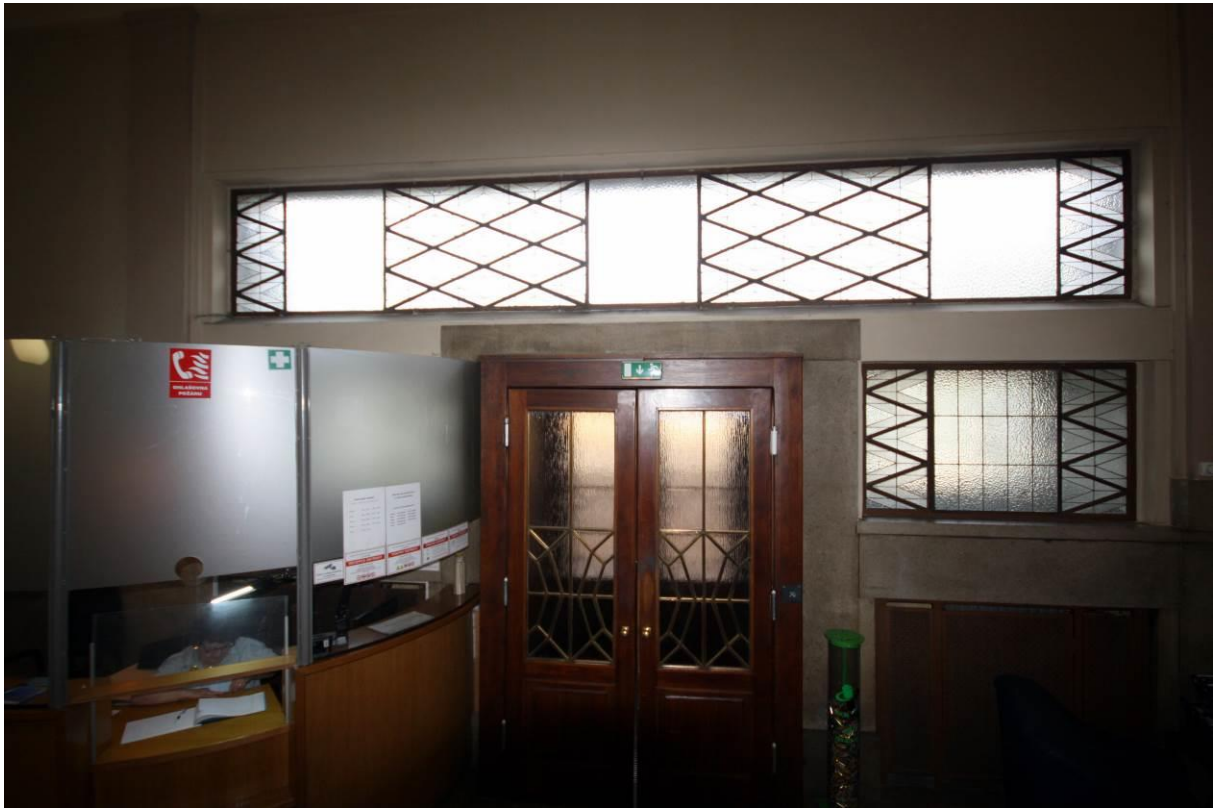
Pohled na čelní stěnu v okolí vchodu z haly budovy (na levé straně nepůvodní zabudovaná vrátnice zakrývající symetricky umístěné okno vedle vchodu)
