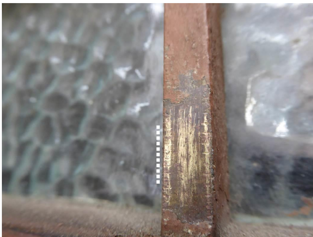
Materiálová sonda mříže umístěné před vitráží prosklení dveří – mosaz (patrný jednoduchý dekor zakrytý druhotnými laky)
