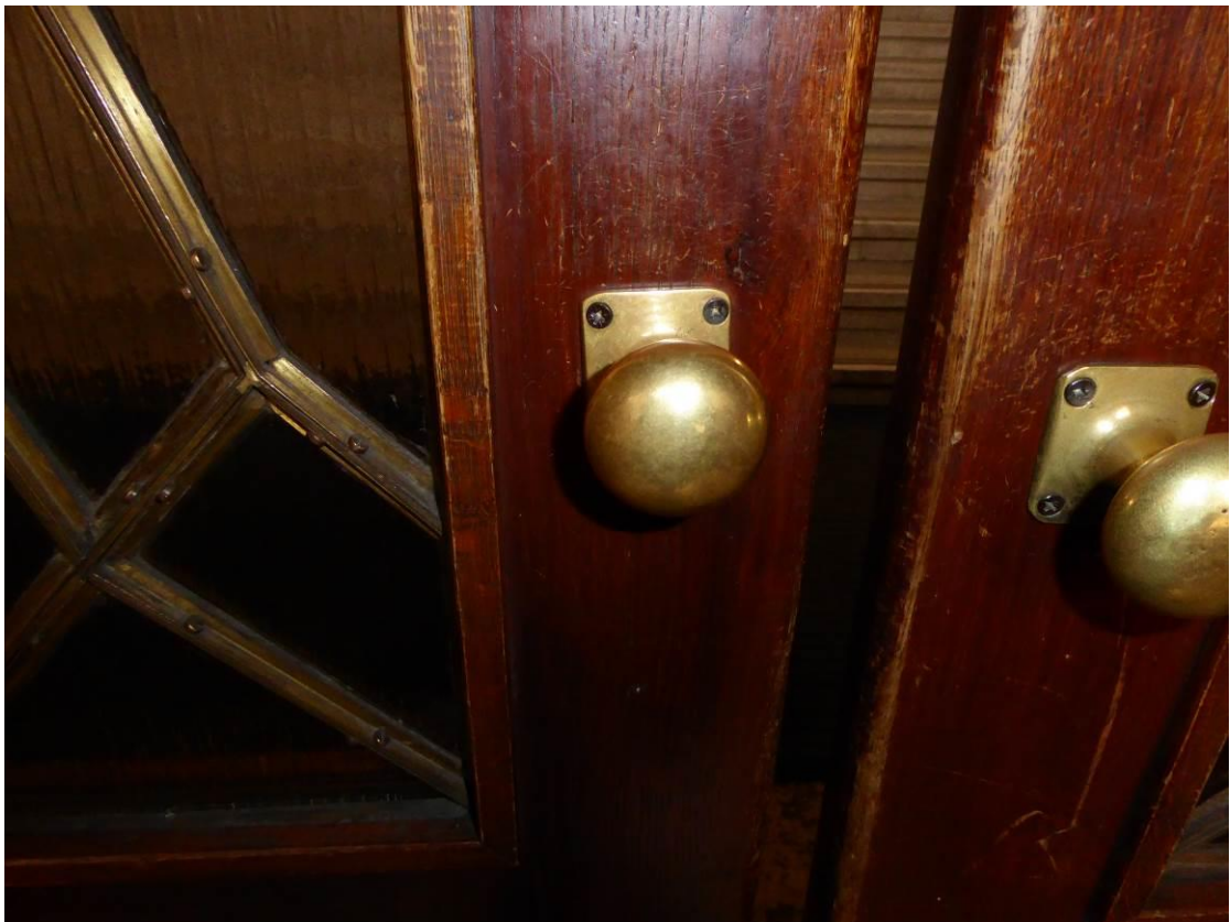
Detail původních úchytů s nepůvodními vruty
