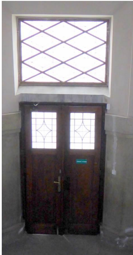
Pohled na dveře a nadsvětlíkové okno z chodby
