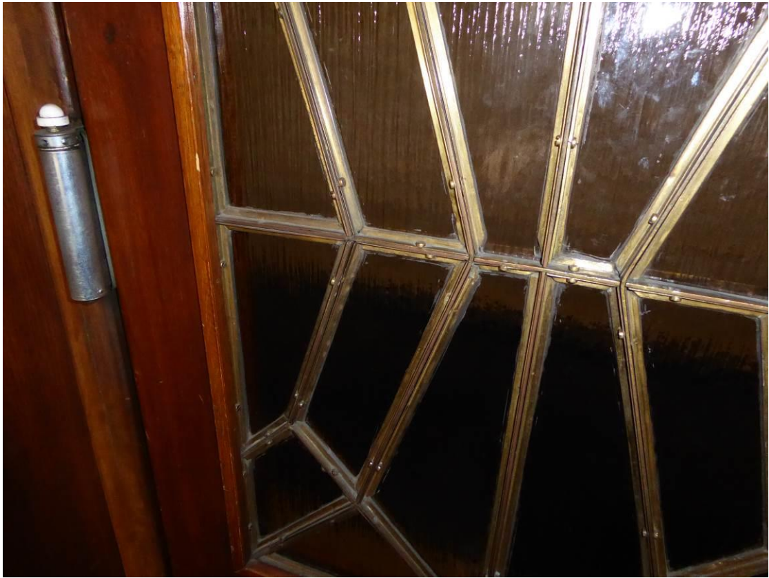
Detail mříže kyvných dveří – mosazná mříž, mosazné lišty; šrouby s válcovou hlavou
