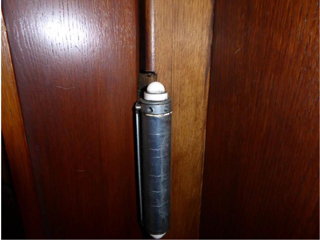
Detail nepůvodního kyvného závěsu
