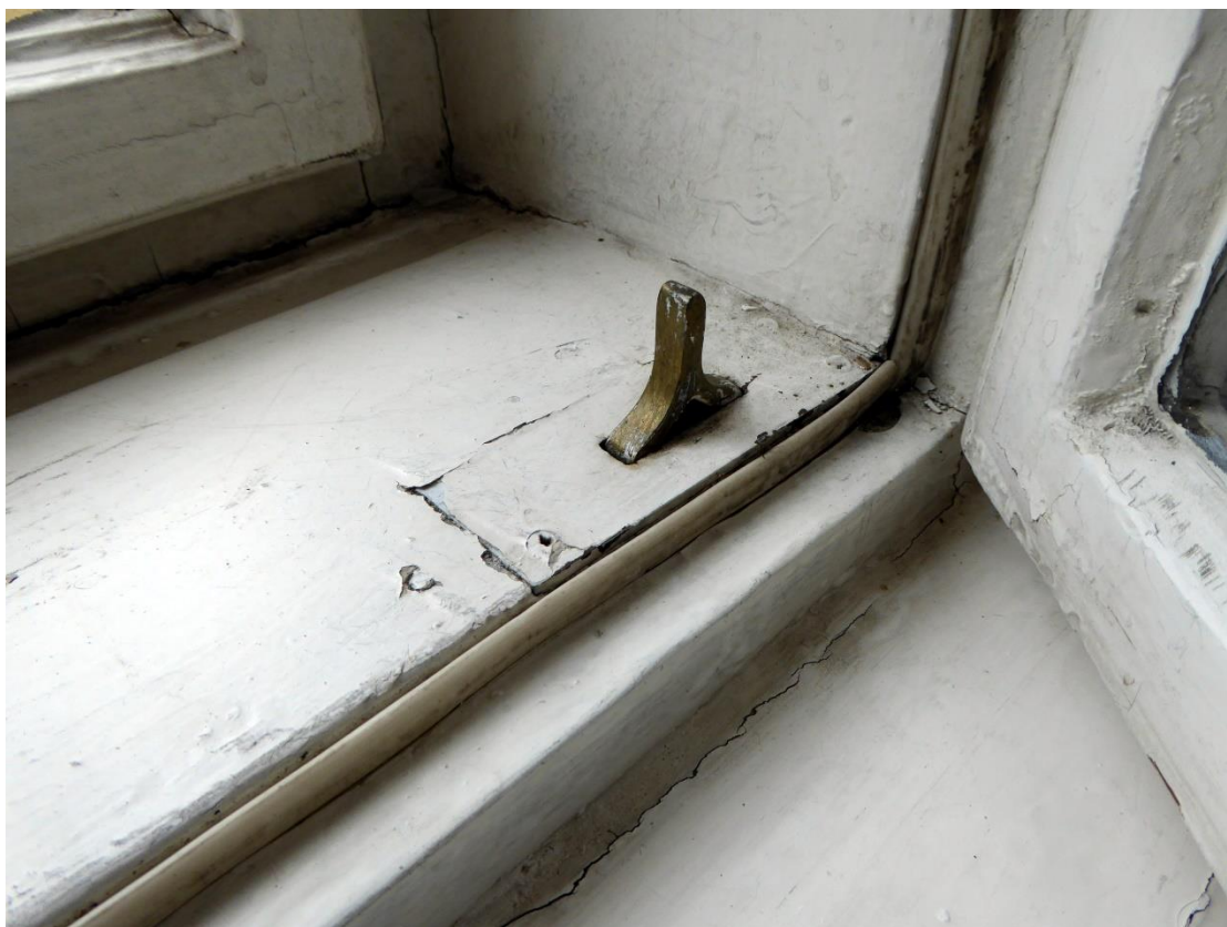
Původní záskočka umístěná na okně obráceném do intravilánu
