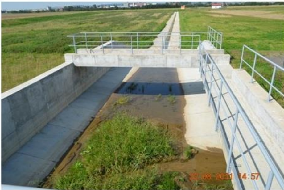
Výustní objekt a žlab před a po vyčištění
