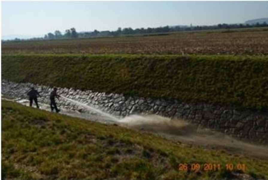
čištění KDV tlakovou vodou
