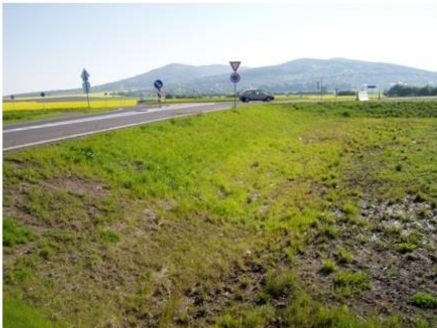
Okružní křižovatka na komunikaci II/490 – dálniční přivaděč
