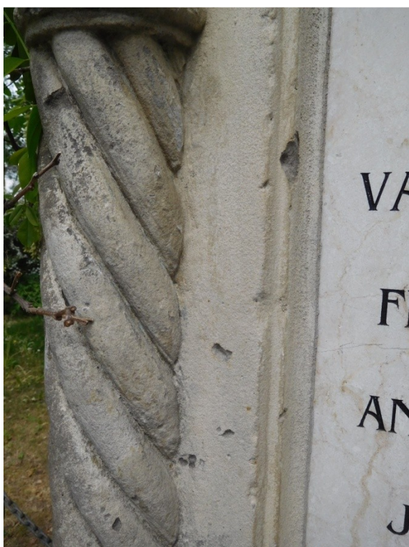
vegetace a drobná mechanická poškození
