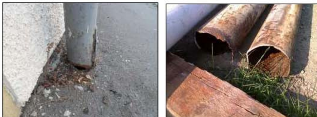
Obrázek 8 – Koroze stožáru
