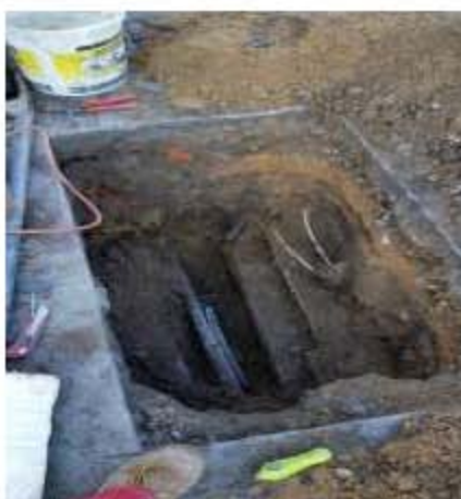
Obrázek 10 - Oprava nefunkčního kabelového vedení
