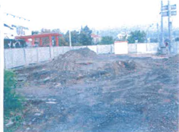
pohled od jihu
