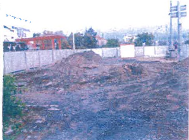
pohled od jihu
