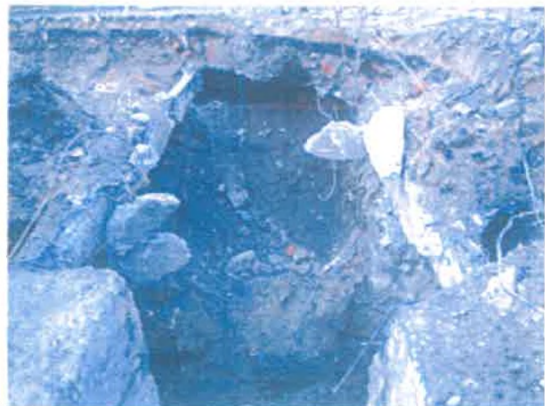
pohled pod severní konstrukci
