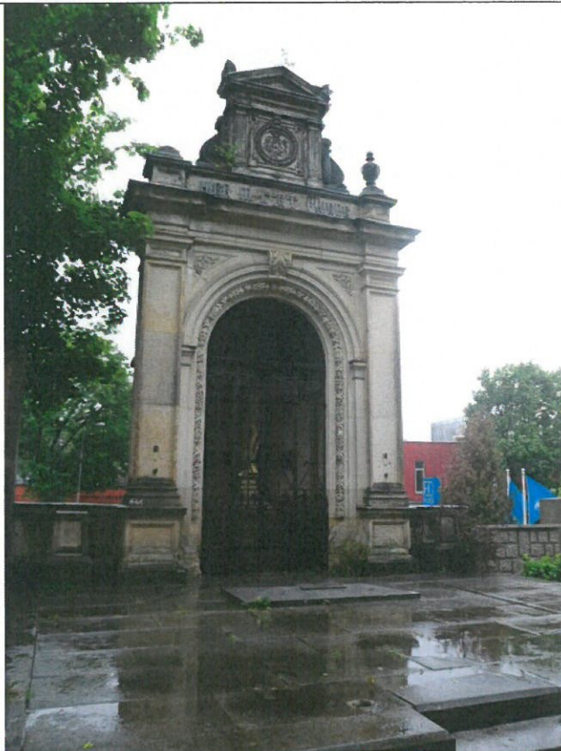
Liebiegova hrobka před rekonstrukcí pláště budovy na jaře v roce 2017
