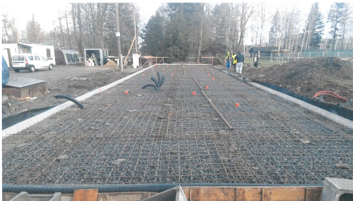
Foto 7 – Betonáž základové desky
