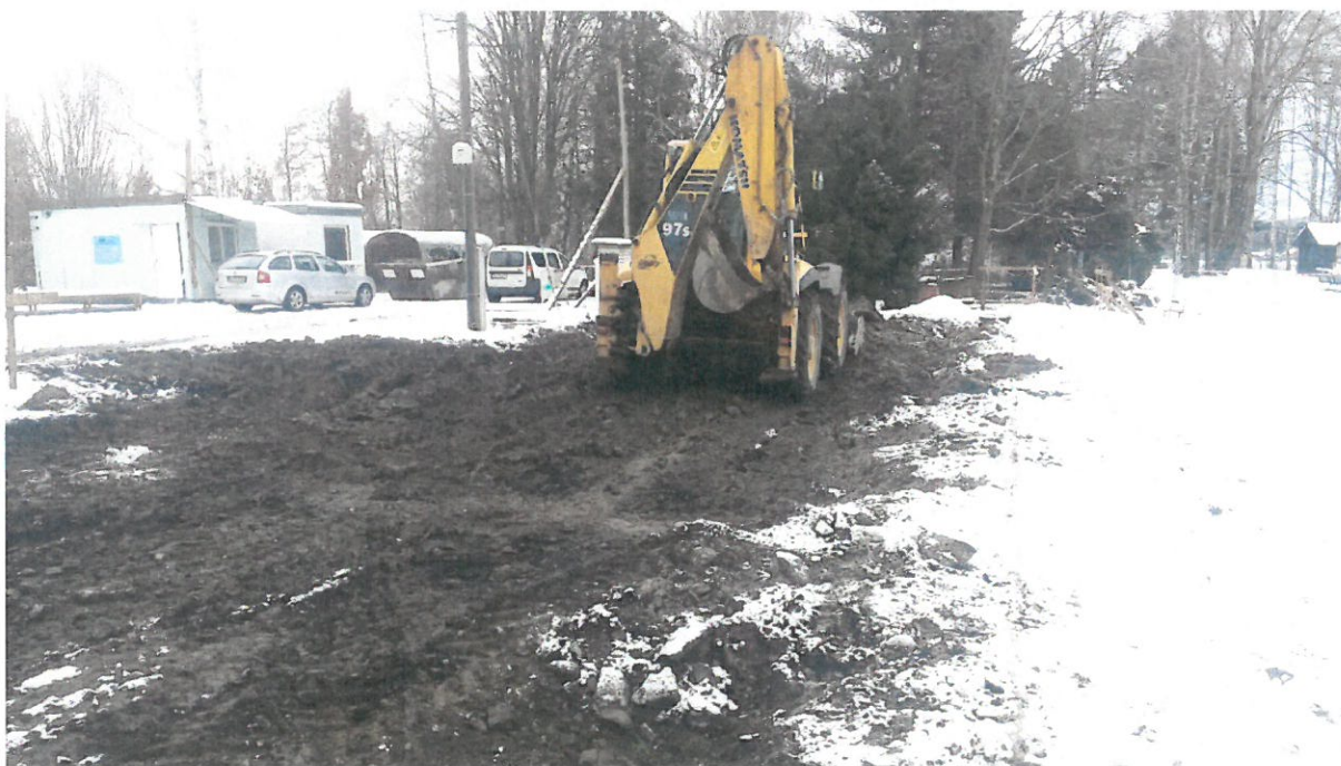
Foto 3 – odstranění stávající základové desky
