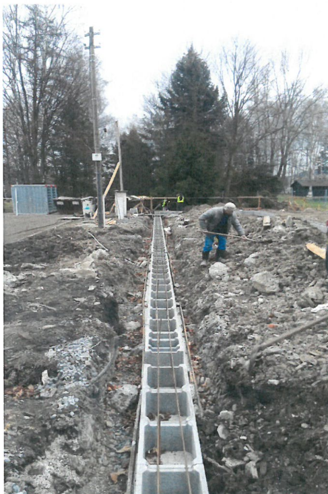
Foto 4 – nový betonový základ
