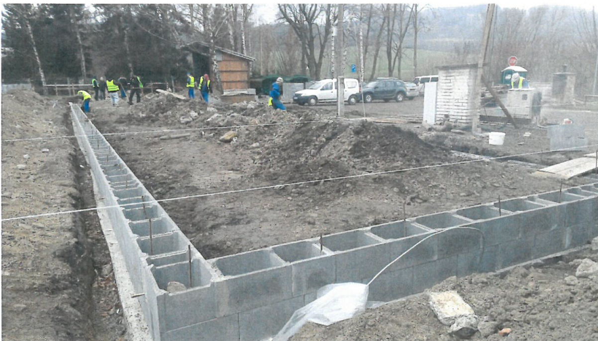
Foto 5, 6 – nové základové pásy
