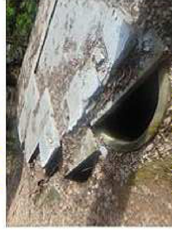
STAVBA ÚMŮRY SUCHÝCH WC
