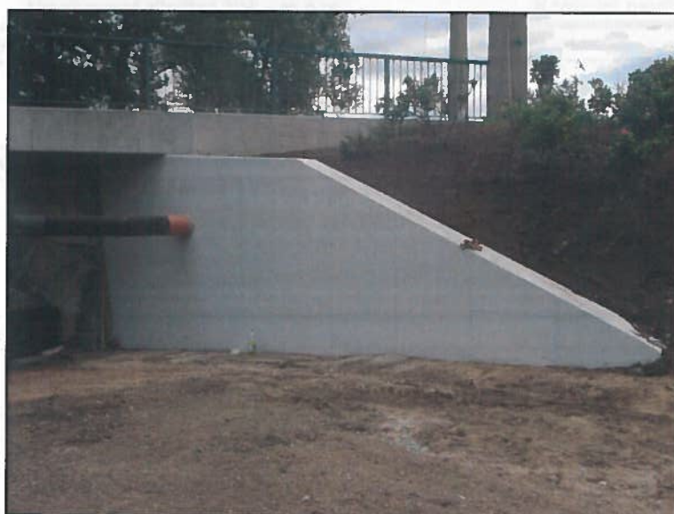
Levobřežní křídlo na povodní straně.
