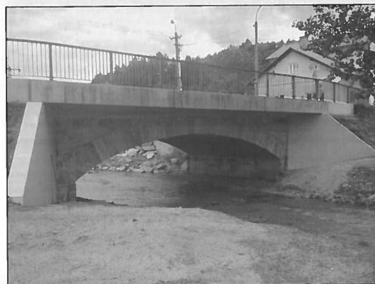
Celkový pohled na vtok.
