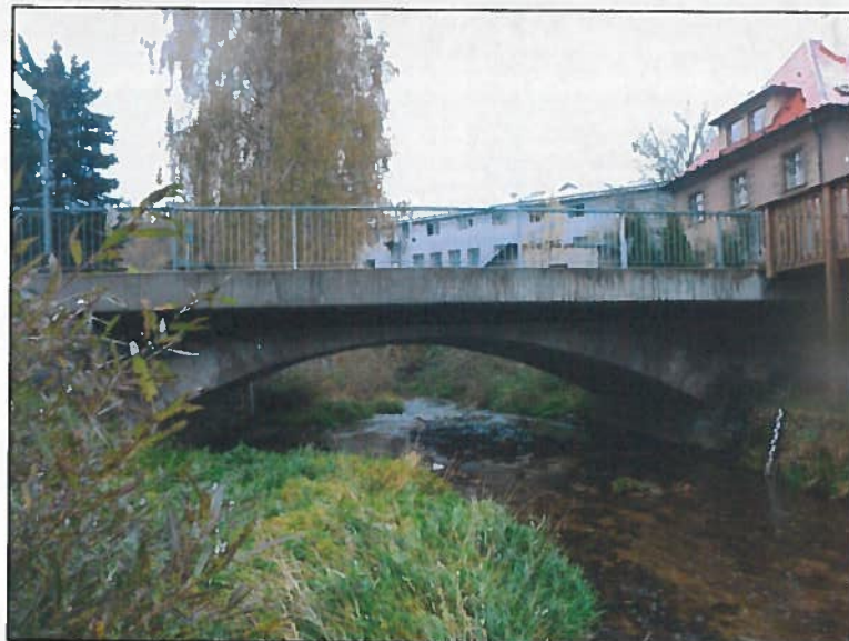
Pohled na vtok
