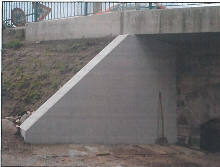
Levobřežní křídlo na návodní straně.
