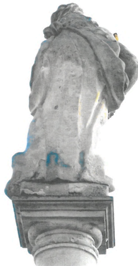
Socha Ecce Homo – biologické napadení, kámen povrchově degradovaný s tmavými depozity.
