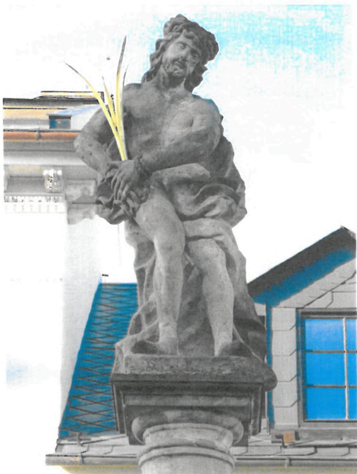
Socha Ecce Homo – biologické napadení, kámen povrchově degradovaný s tmavými depozity.
