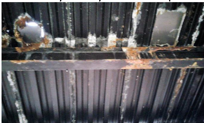
Foto: stav nosných ocelových konstrukcí stropů a střechy
