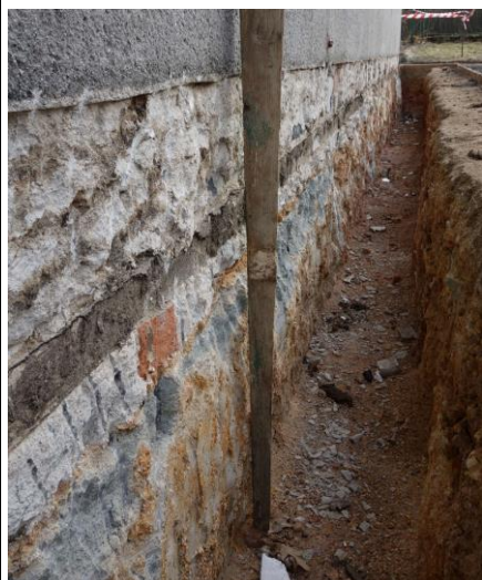
Foto stávající stav
