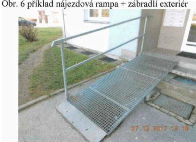
Obr. 6 příklad nájezdová rampa + zábradlí exteriér
