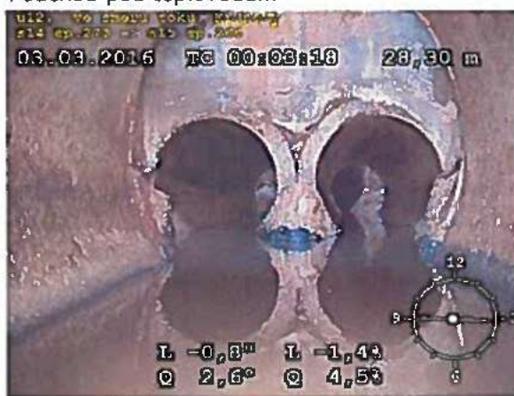
Podchod pod teplovodem
