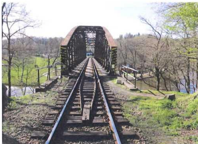
Pohled ve směru staničení
